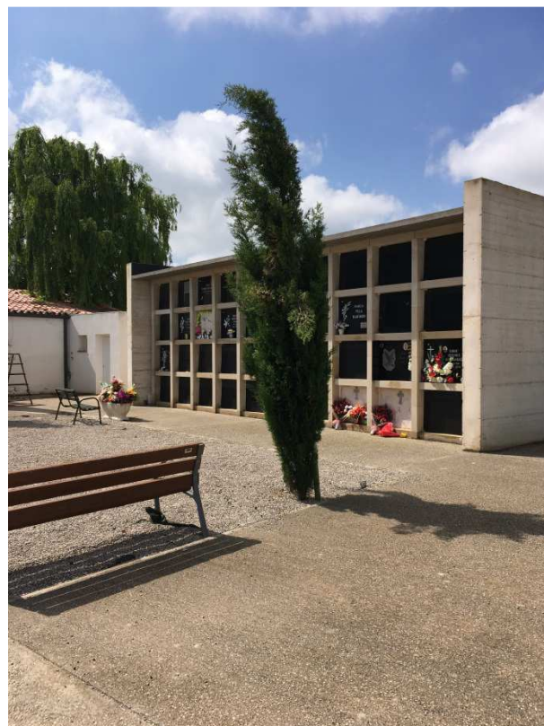
Figura 5.5. La zona de nínxols de nova construcció.
