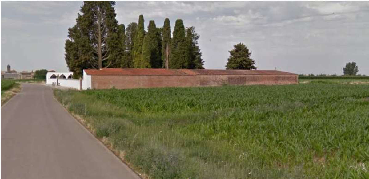
Fotografia 2: estat actual vista sud-oest
