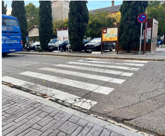
Imatge 13. Carrer de F. Soler i Puigdollers sense gual adaptat en el pas de vianants.
