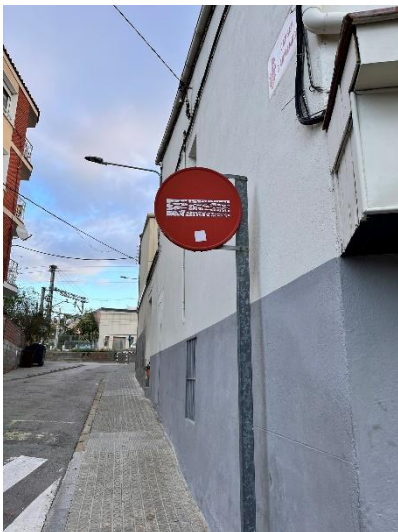
Imatge 3. Senyal vertical en mal estat
