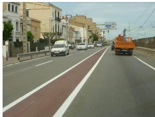
Imatge 46. Exemples de mesures de fàcil aplicació per l'estretament d'amples de calçada
