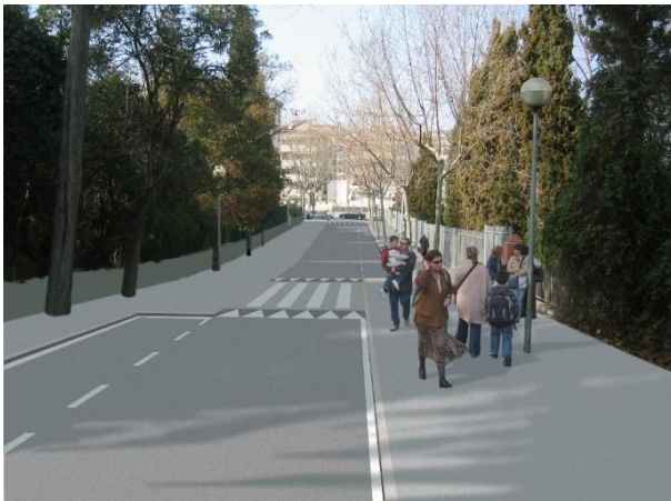
Imatge 61. Carrer amb sentit únic i aparcament alternatiu, que permet l'ampliació de voreres
