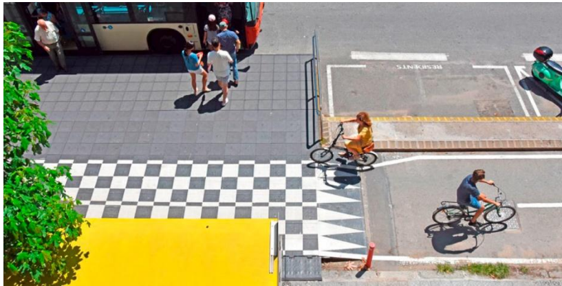
Imatge 60. Exemple de carril integrat a Barcelona. Plataforma per accedir l'autobús i integració del carril pedalable. Solució de Zicla, Sistema Vectorial
