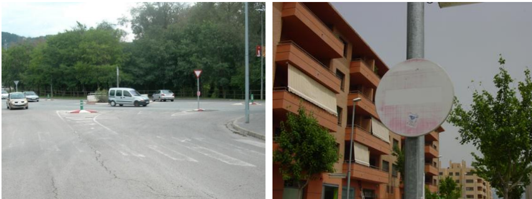
Imatge 52. Senyalització en estat deficient
