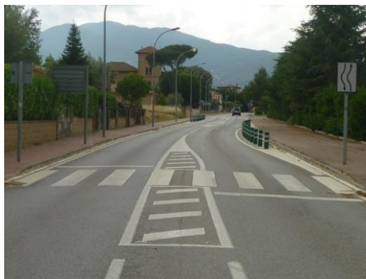
Imatge 46. Exemples de mesures de fàcil aplicació per l'estretament d'amples de calçada
