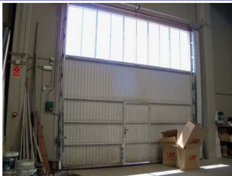
Porta basculant d'accés a la nau de la brigada municipal
