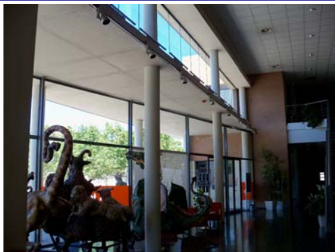
Tancaments façana entrada teatre i porta sense vestíbul
