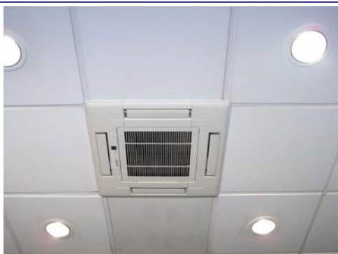
Downlights amb LED de 10W, segona planta
