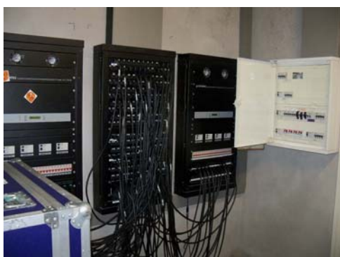
Controls equip de so i subquadre elèctric escenari
