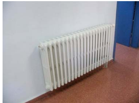
Radiador distribuïdor, primera planta
