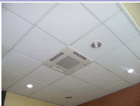
Cassete i comandament climatització despatx, segona planta
