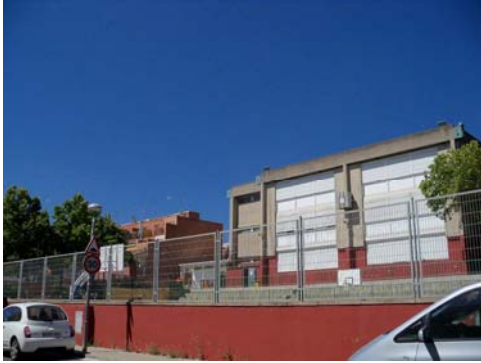
Tancaments façana est edifici
