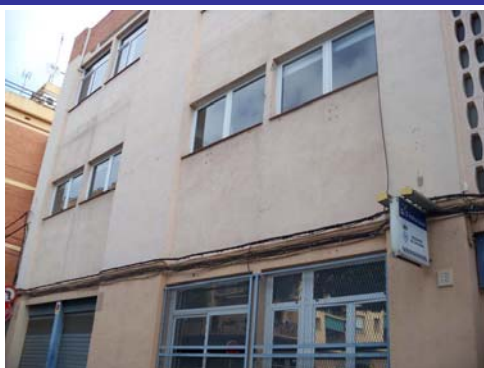
Tancaments façanes edifici
