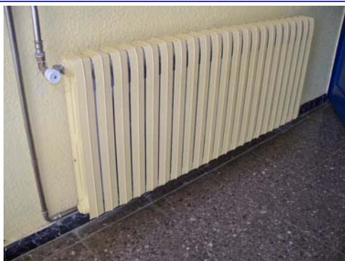
Radiador fosa de ferro vestíbul planta baixa edifici educació primària
