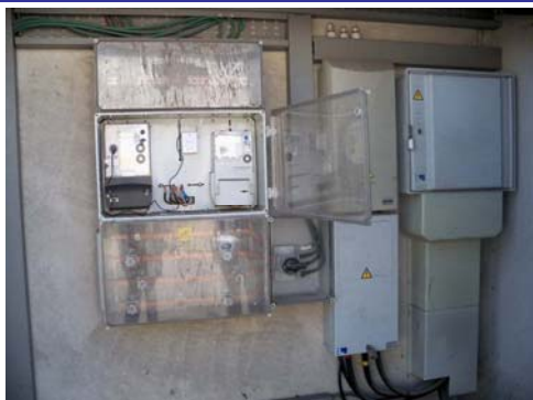
Armari exterior comptador CIRWATT
