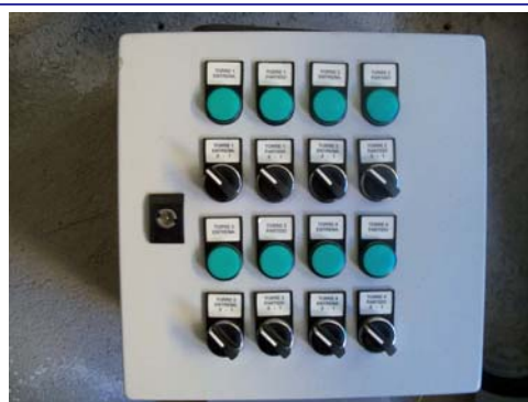
Quadre elèctric control il·luminació torres
