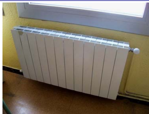
Radiador alumini aula planta baixa edifici educació primària
