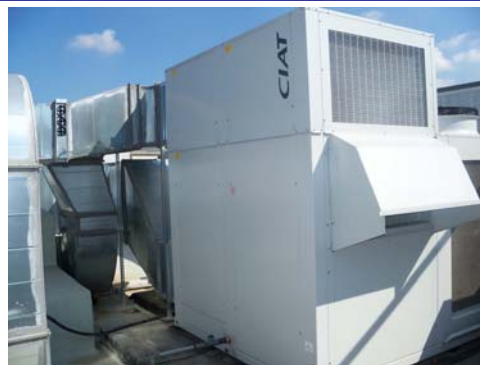
Unitat centralitzada de climatització dels espais comuns de l'edifici
