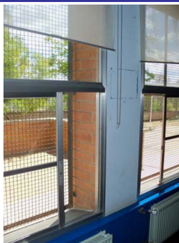
Radiador ferro aula edifici educació infantil
