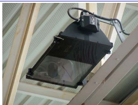
Focus halogenurs metàl·lics 400W pista
