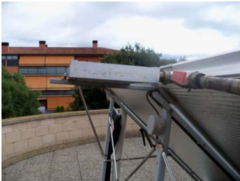
Reixeta de dissipació de la calor col·lectors
