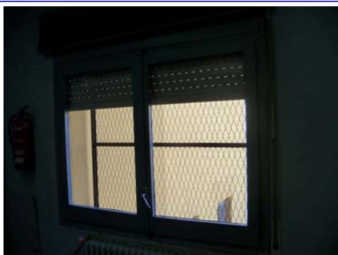
Finestra distribuïdor, primera planta
