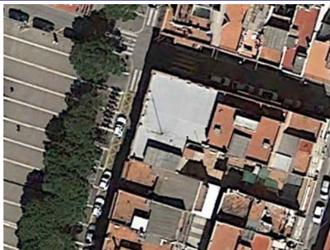
Coberta plana edifici. Possible ubicació de les instal·lacions solars
