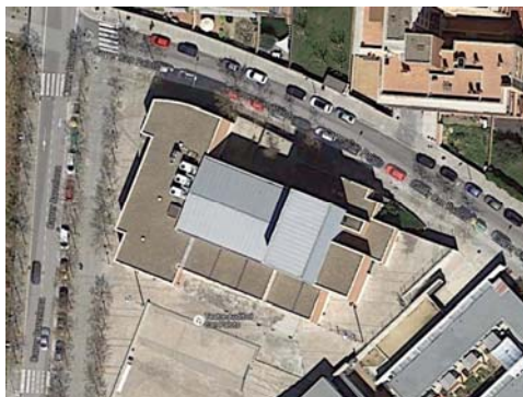
Coberta a dues aigües edifici
