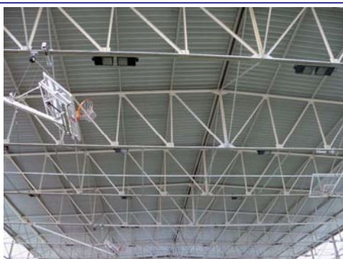
Focus halogenurs metàl·lics 400W pista
