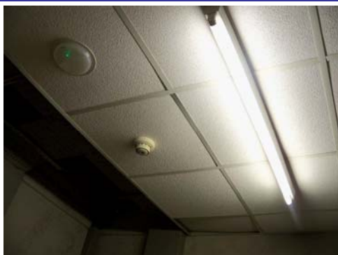
Fluorescent 36W sala quadres elèctrics, planta baixa
