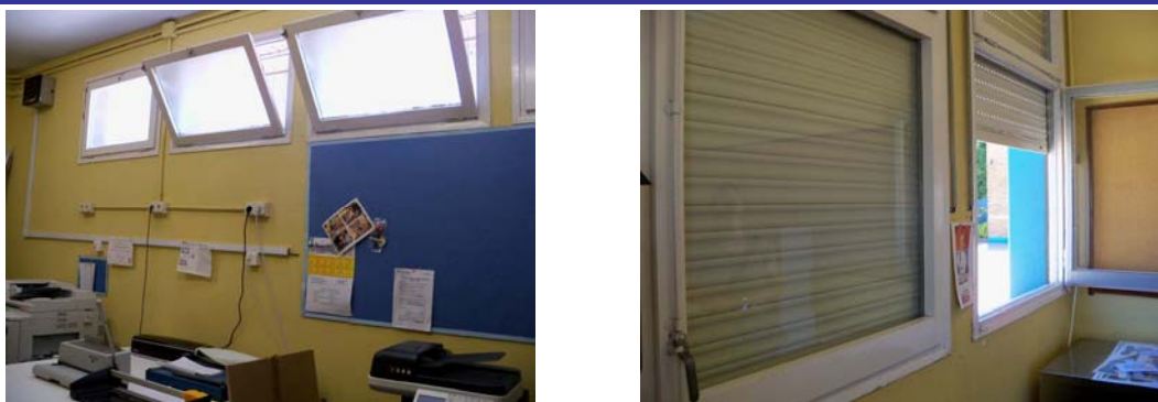
Finestres de fusta, edifici de direcció
