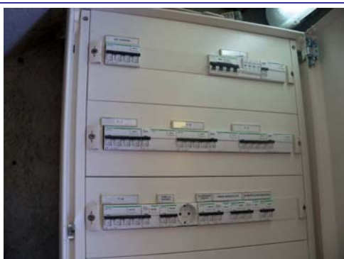
Quadre elèctric control il·luminació torres
