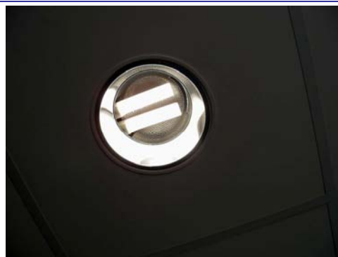
Downlight amb bombetes de LED de 10W vestíbul Promoció Econòmica, planta baixa
