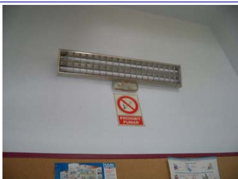
Fluorescents 36W escala accés a primera planta
