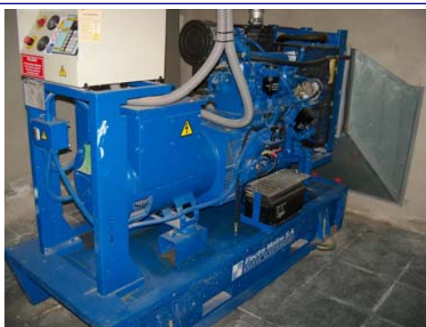
Grup electrogen d'emergència
