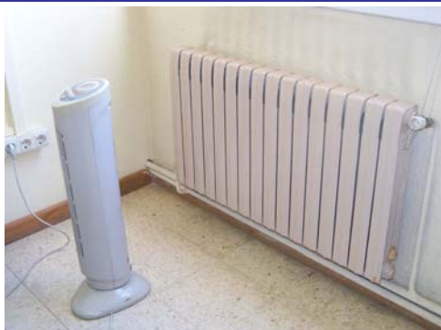
Radiador de ferro i radiador elèctric de suport despatx Serveis Socials, segona planta
