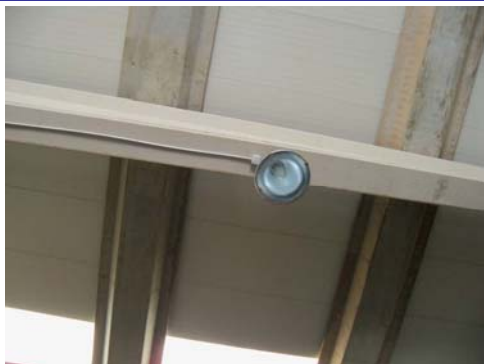
Campana industrial de vapor de mercuri de 400W
