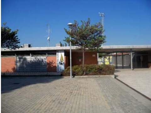
Accés a les instal·lacions
