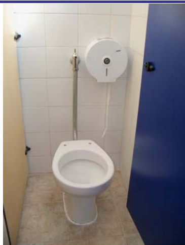
WC lavabos edifici principal
