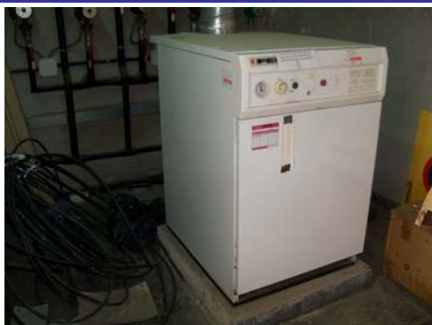
Caldera gas natural FER i circuits de calefacció de l'edifici
