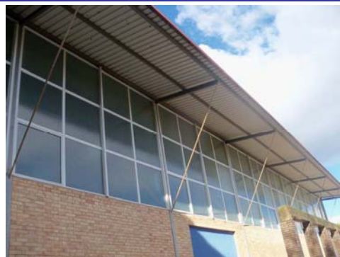
Tancaments amb vidre i perfil metàl·lic façana
