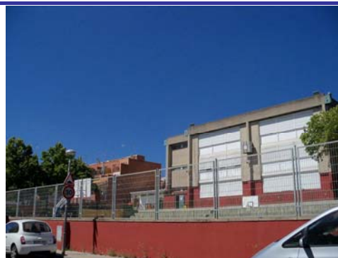
Edifici CEIP Joan Miró
