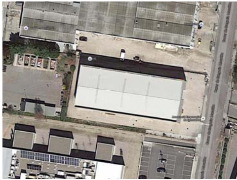
Coberta a dues aigües edifici
