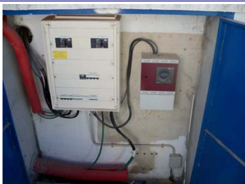
Quadre elèctric general i bateria de condensadors
