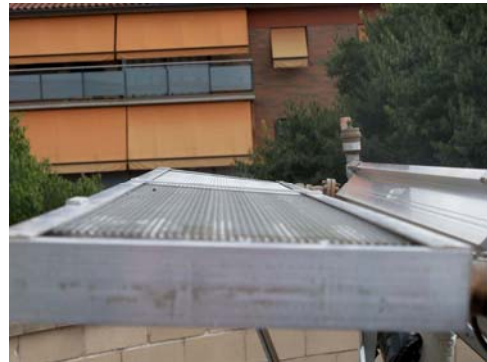
Reixeta de dissipació de la calor col·lectors
