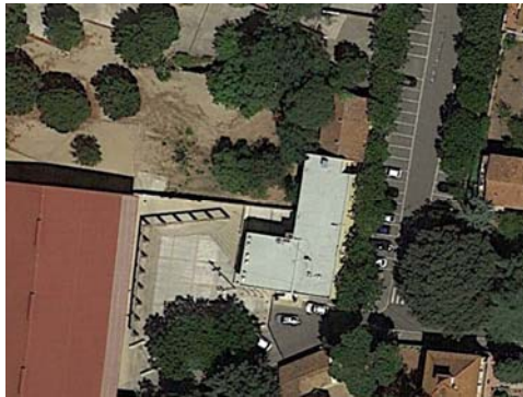
Coberta plana edifici
