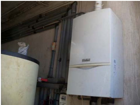
Caldera mural de gas natural Vaillant i radiador d'alumini oficines
