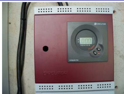
Quadre elèctric general i bateria de condensadors
