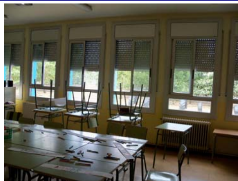
Finestres d'alumini planta baixa, edifici d'educació primària
