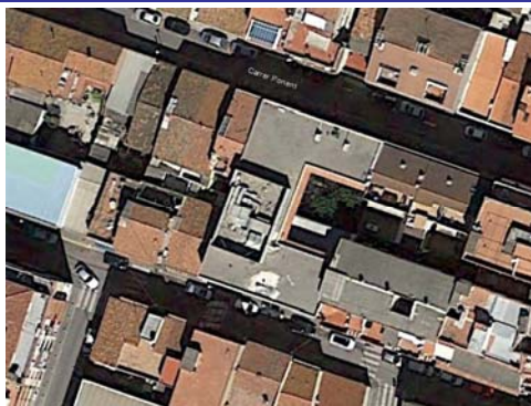
Coberta plana edifici
