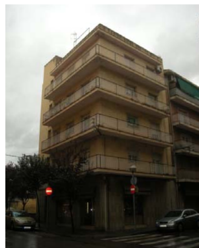
Edifici de PB+4PP a la Barriada Nova (carrer de la Riera)
