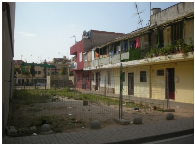
Habitatges amb en mal estat de conservació a la Barriada Nova (carrer del Sol / plaça d'Europa)
