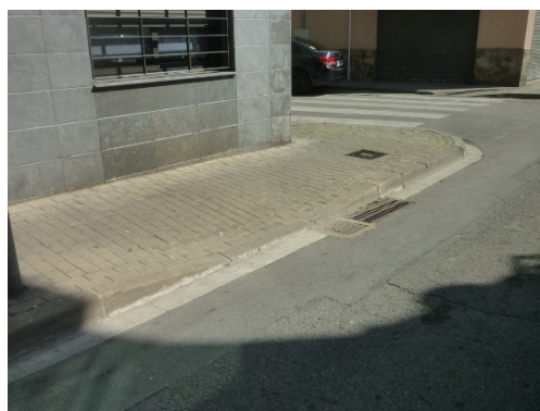
Imatge 134. Les cantonades han estat rebaixades per millorar l'accessibilitat.
