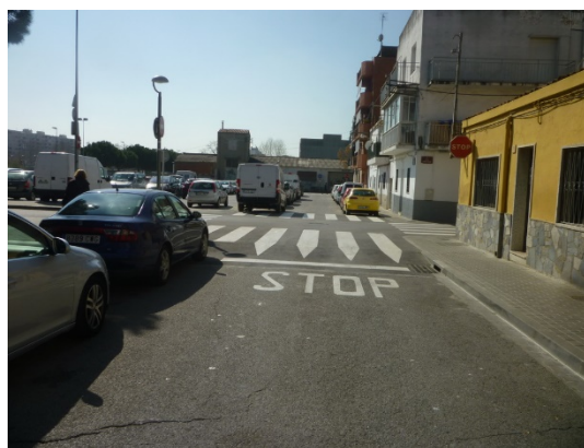
Imatge 76. Vista oposada del ramal d'Unió. Cal estrènyer el carril de circulació pintant les places d'aparcament.
