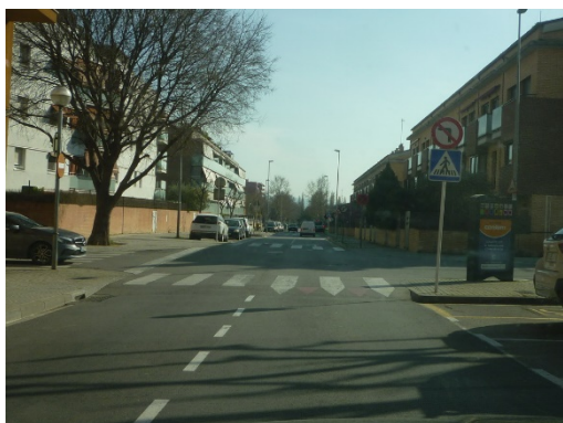
Imatge 15. Bona senyalització i definició d'espais amb marques. Carrer de Barcelona.
