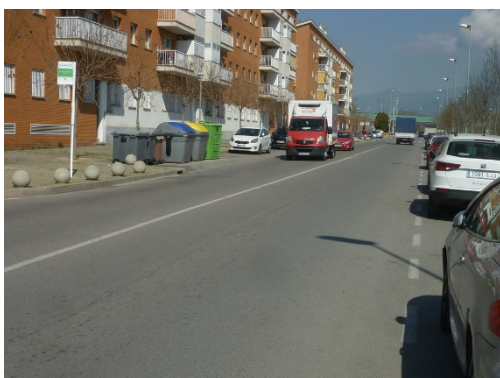
Imatge 139. Ramal nord, sense pas de vianants.
