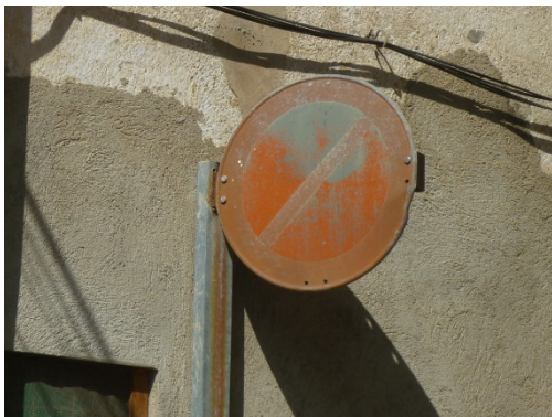
Imatge 127. Senyal envellit que caldria substituir.
