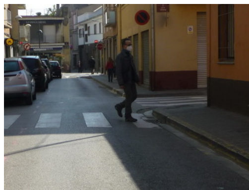
Imatge 12. Desnivell actual entre pas i vorera a Molí de la Sal.
