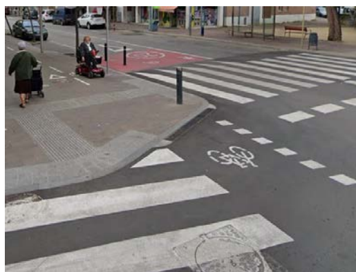
Imatge 82. Vegeu les marques vermelles i també les pilones per evitar l'estacionament abans del pas de vianants.
