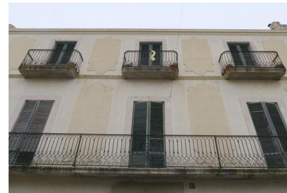
Exemples acabats paraments existents (113EA)
