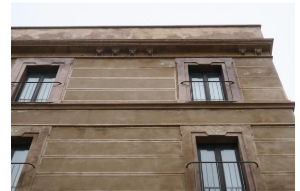
Exemples acabats paraments existents (117EA)
