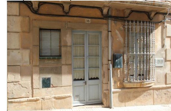
Exemples acabats paraments existents (145EA)
