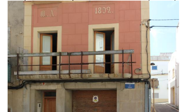
Exemples acabats paraments existents (167EA)
