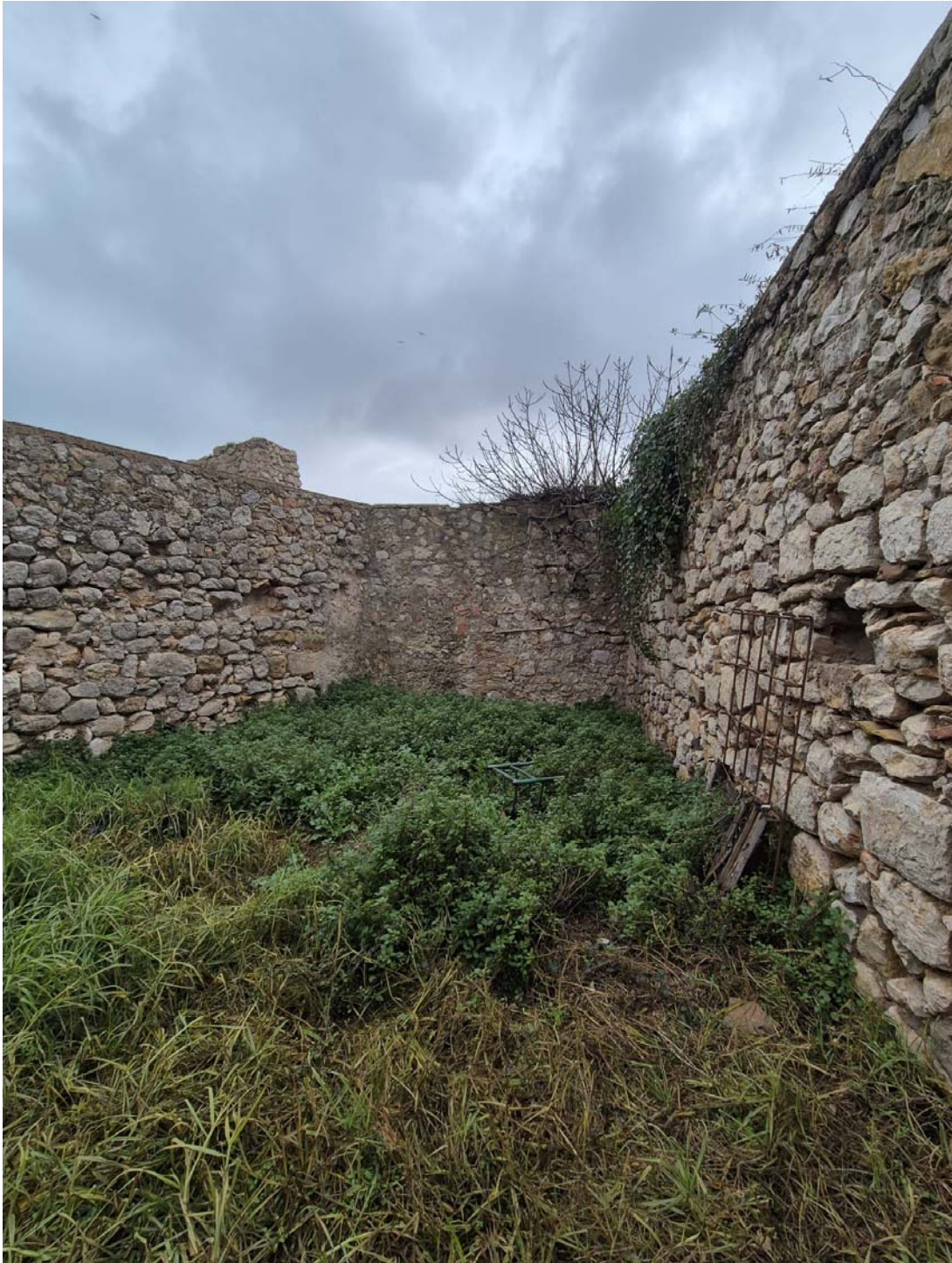
Pati interior, costat sud.
