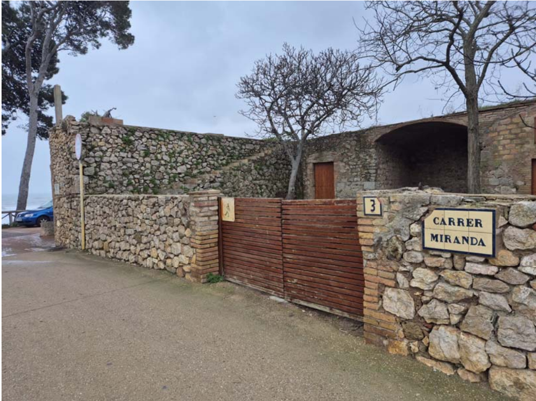
Façana principal, Carrer Miranda. Lateral nord
