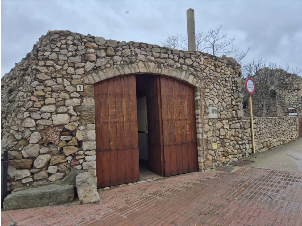
Portal accés sala exposicions – Façana nord
