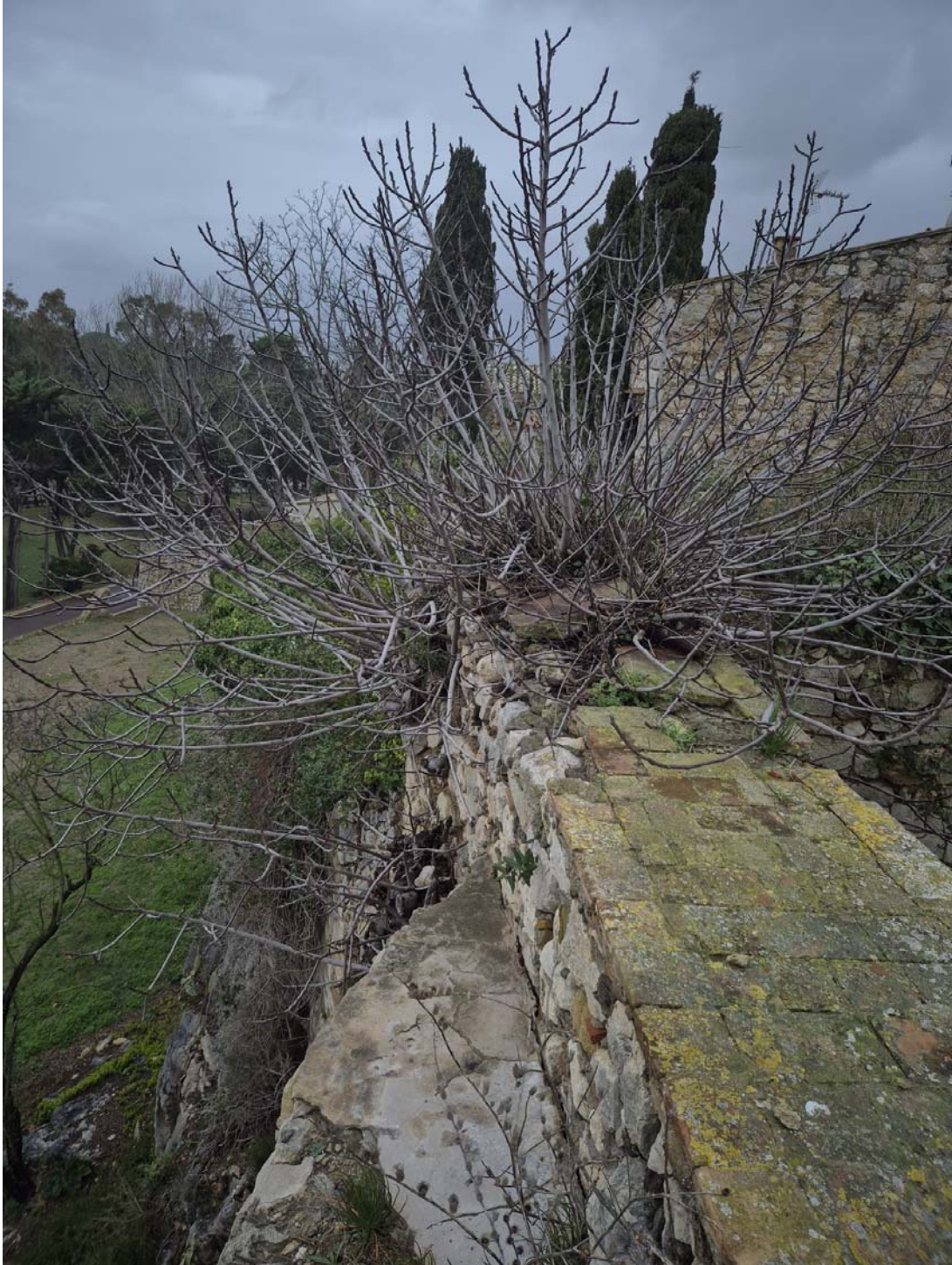
Figueres a retirar. Coronament muralla lateral sud.
