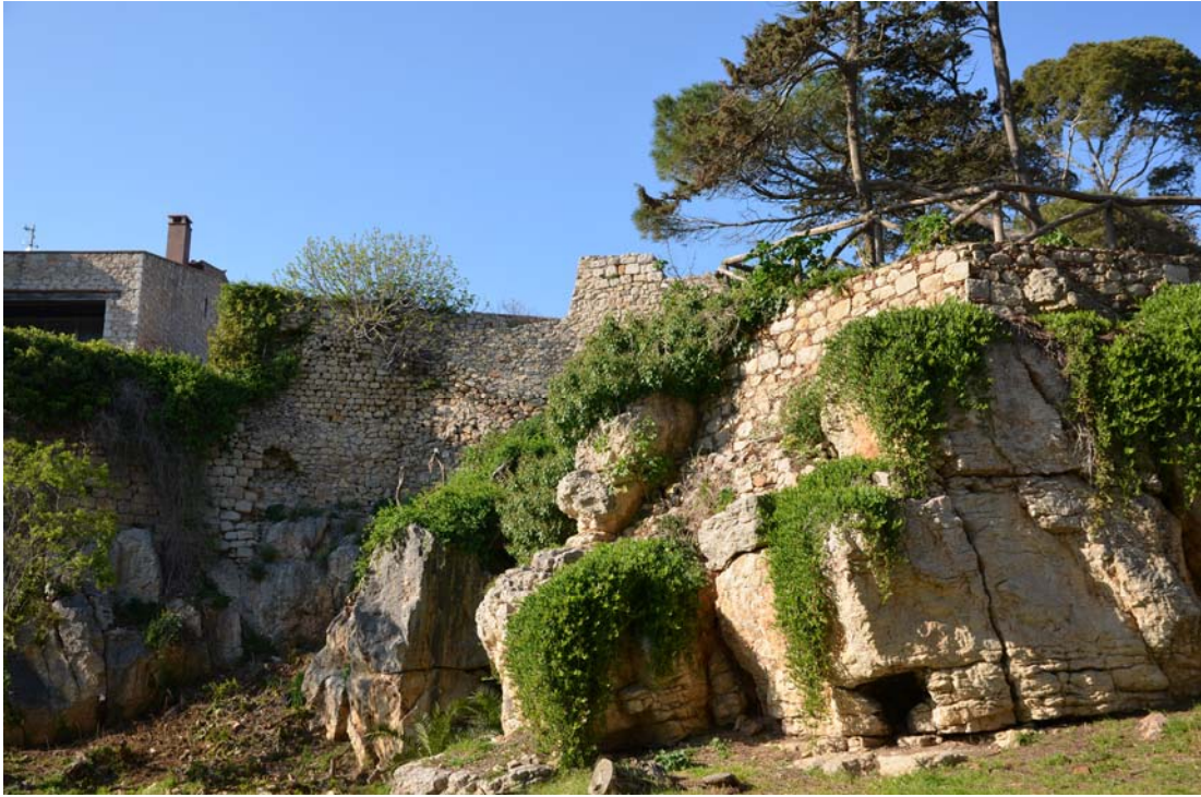
Façana sud – muralla
