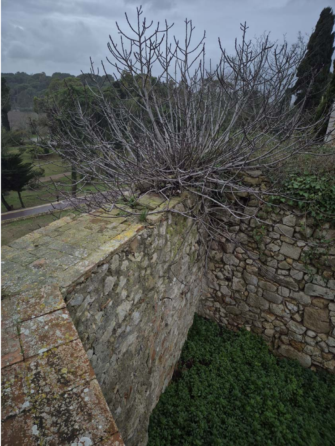
Figueres a retirar. Coronament muralla lateral sud.
