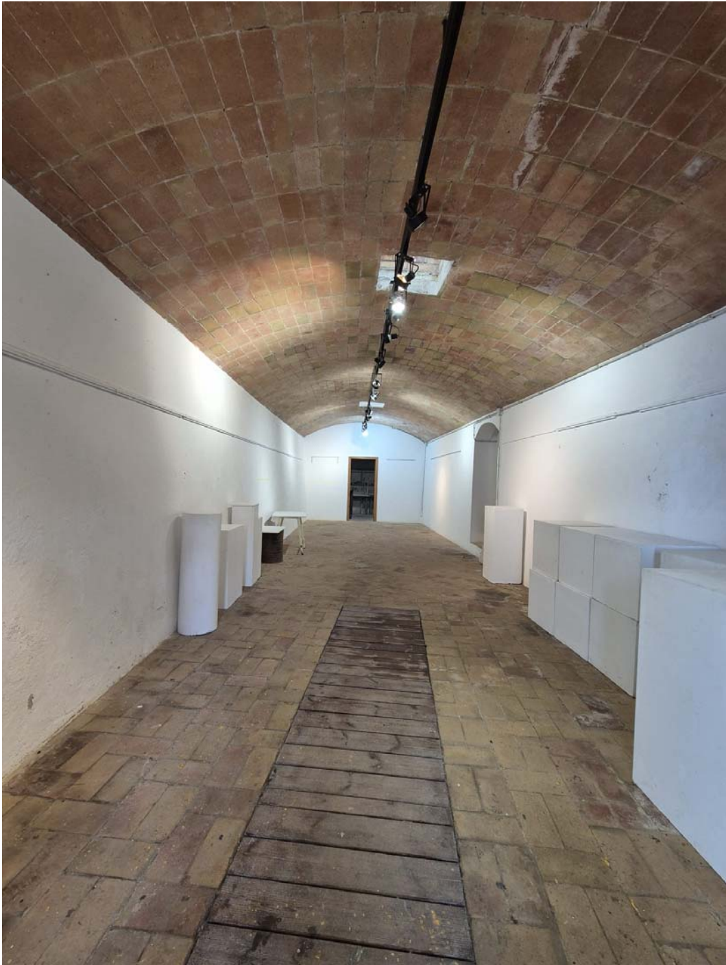
Sala d'exposicions, edificació principal.
