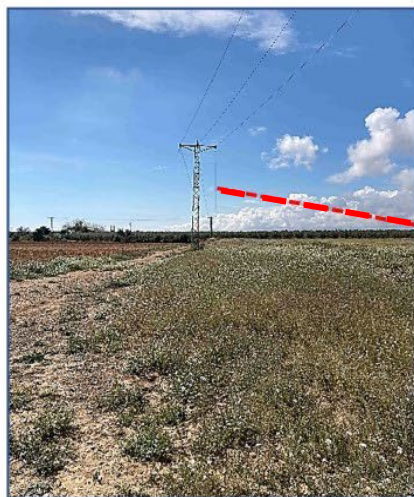
Torre metàl·lica existent
