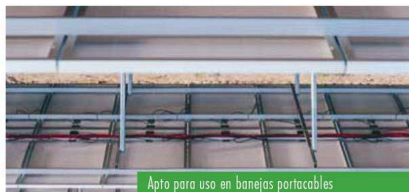
Conexión del panel al inversor
