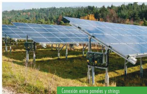
Conexión entre paneles
