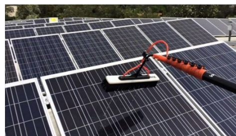
Sistema de neteja amb aigua pura i bastons telescòpics
