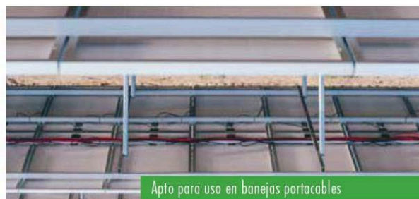
Conexión del panel al inversor
