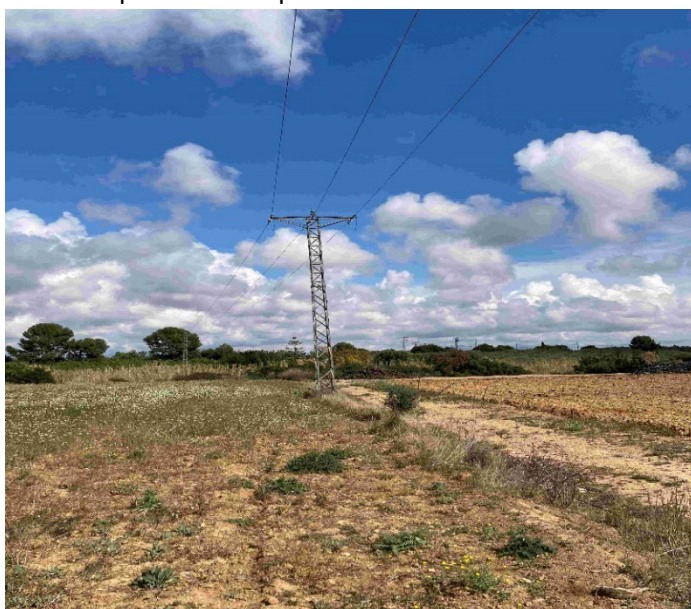
Torre que passa per la finca, on es farà la connexió a la PSF
