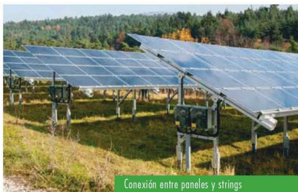
Conexión entre paneles
