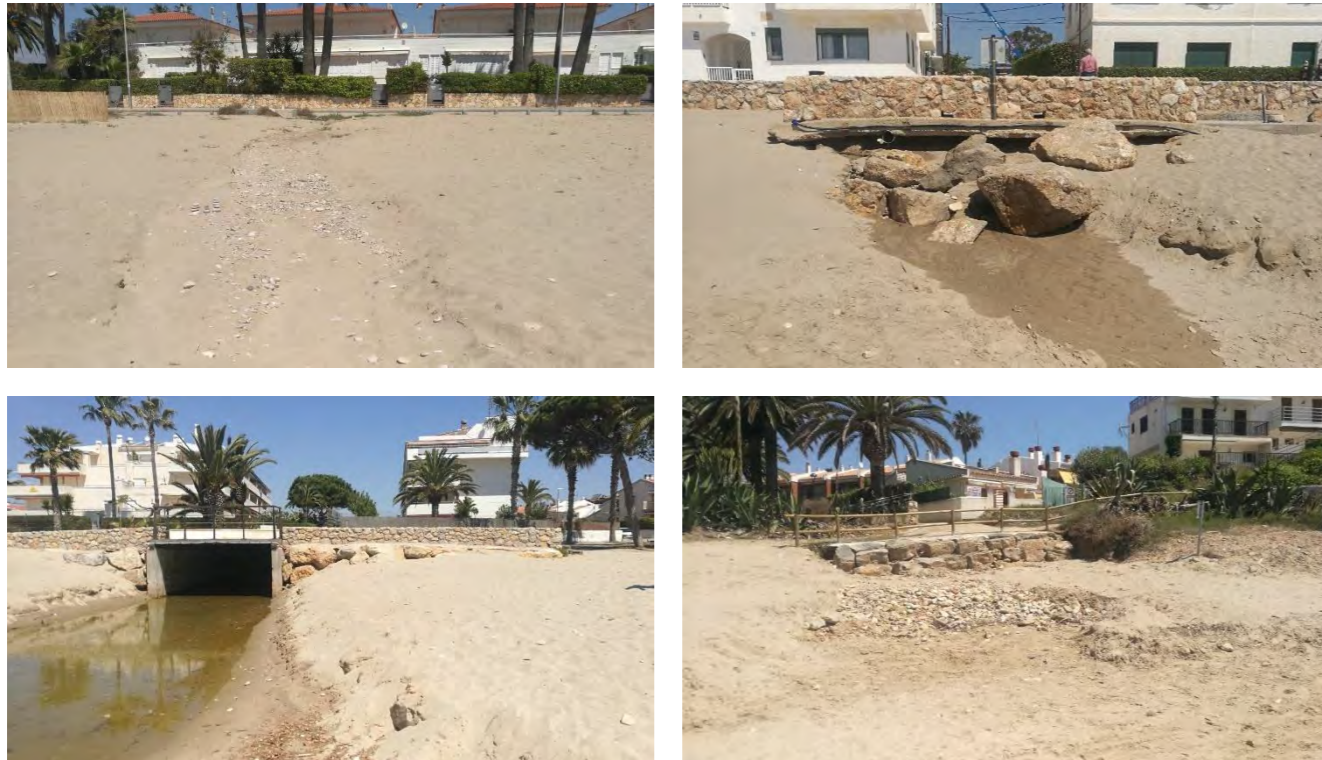
Erosió i formació de xaragalls damunt la platja degut als escorrentius de pluvials. De dalt a baix i esquerra a dreta: c. dels Pescadors, accés a platja des de Botigues de Mar, torrent de la Rasa i final de passatge de vianants. Font: elaboració pròpia (maig 2021)
