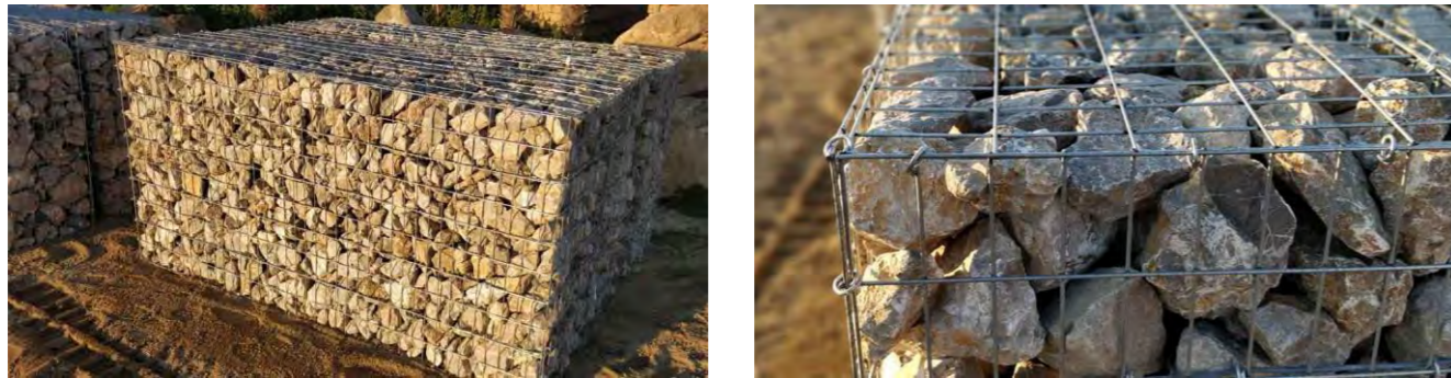
Imatges d'estructura de gabions omplerts de pedres. Font: Google Images
