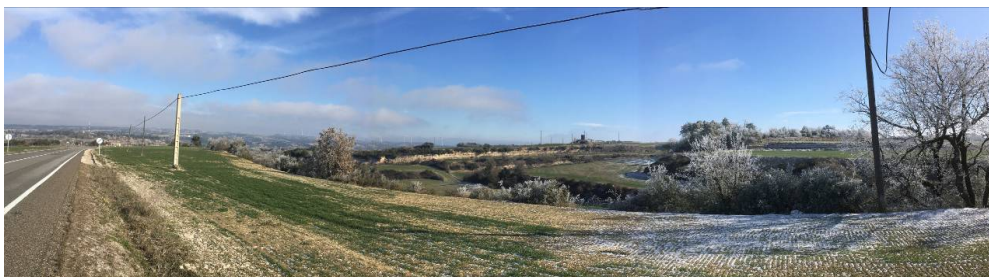
Vista 2. carretera B-221
