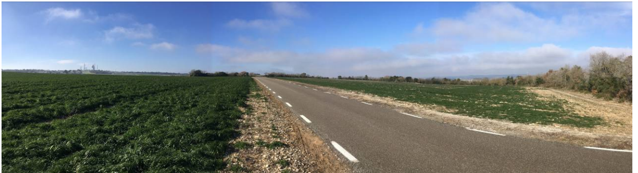
Vista 1. carretera BV-2234
