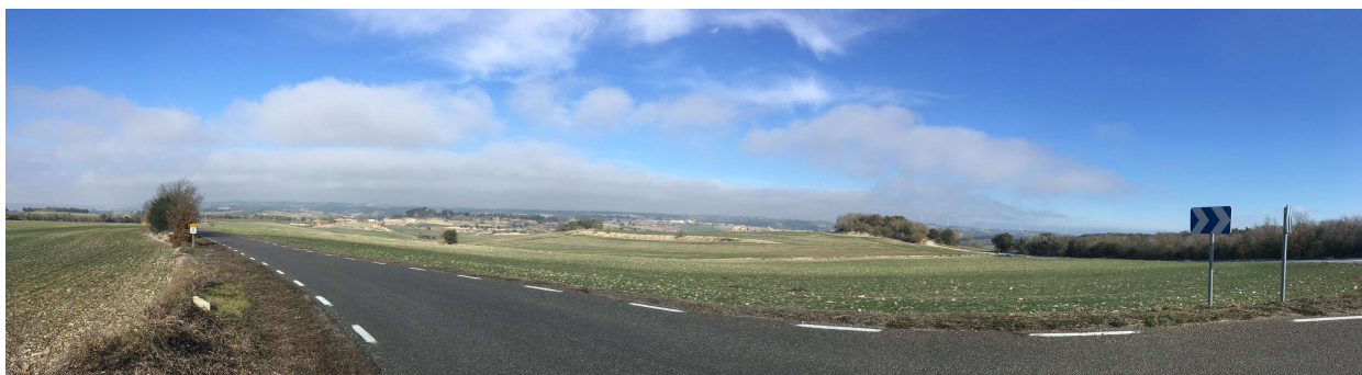
Vista 6. carretera BV-2234
