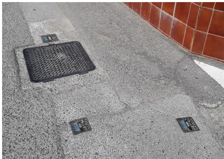
Il·lustració 19: Hidrant (superior) i vàlvules de tall (inferior).
