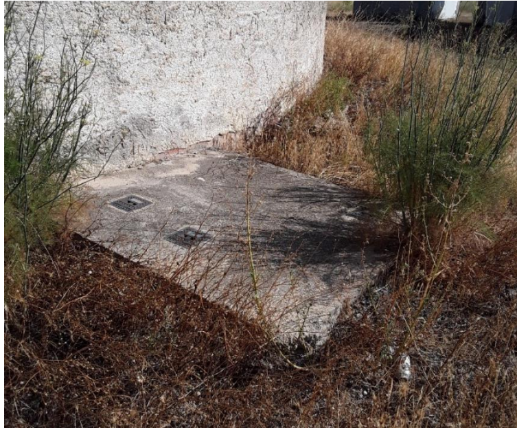
Il·lustració 12: Punt on es troba la trifurcació de la canonada de FDØ200 que surt del dipòsit Nou.
