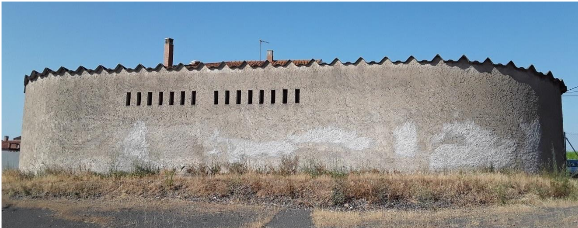
Il·lustració 14: Edificació tancada de planta el·líptica on es troben els dos dipòsits. Es pot observar la coberta de fibrociment.
