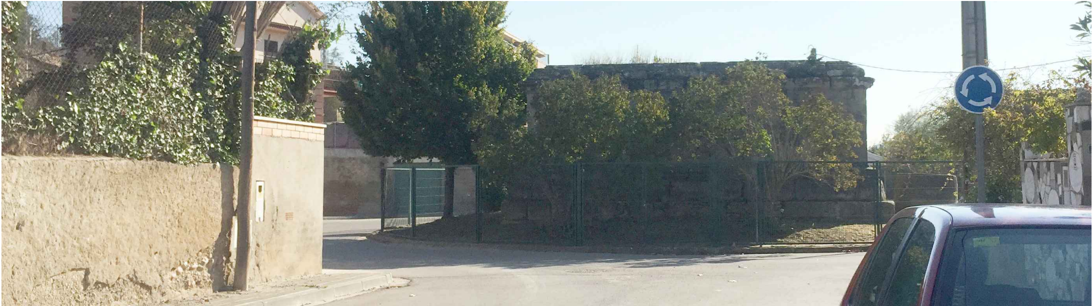
IMATGE FAÇANA NORD Font: GAA-16/11/2016
