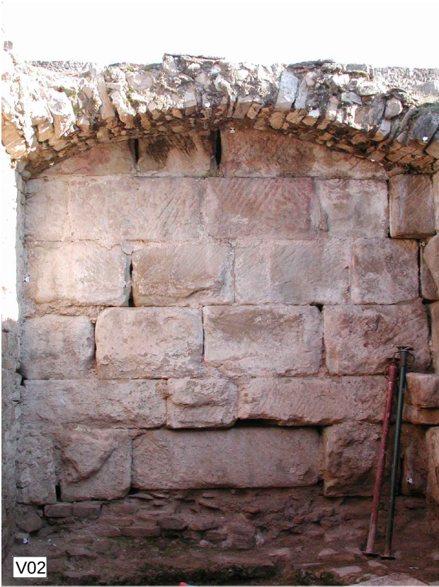
Cantonada interior façana Est Font: SPAL-14/01/2003
