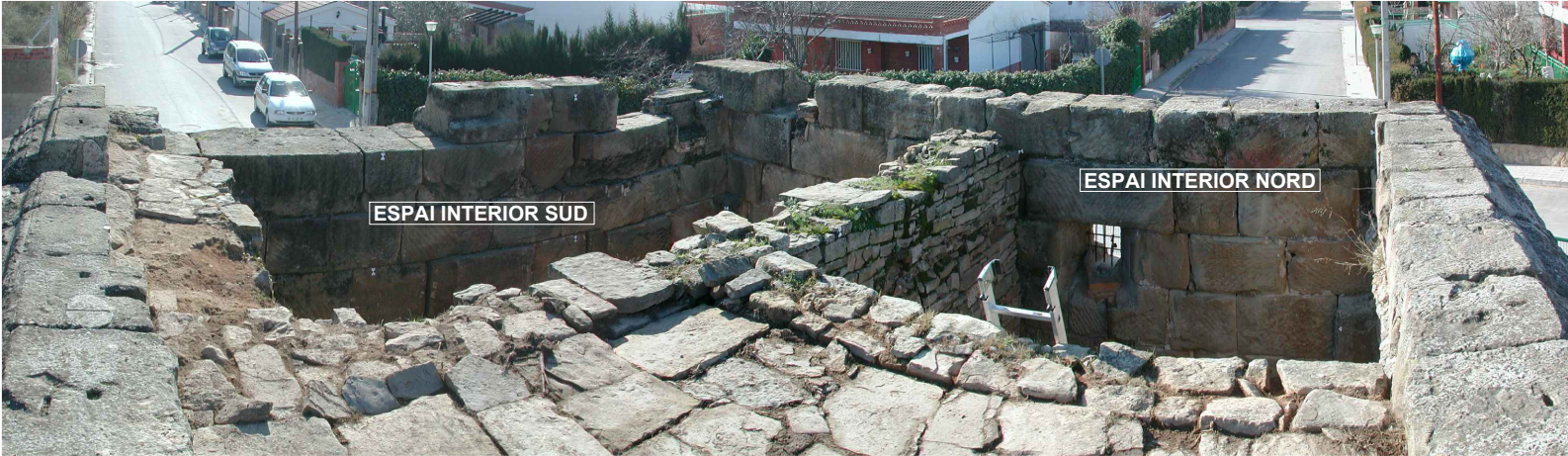
Vista panoràmica de coronació del mur espais Nord i Sud
