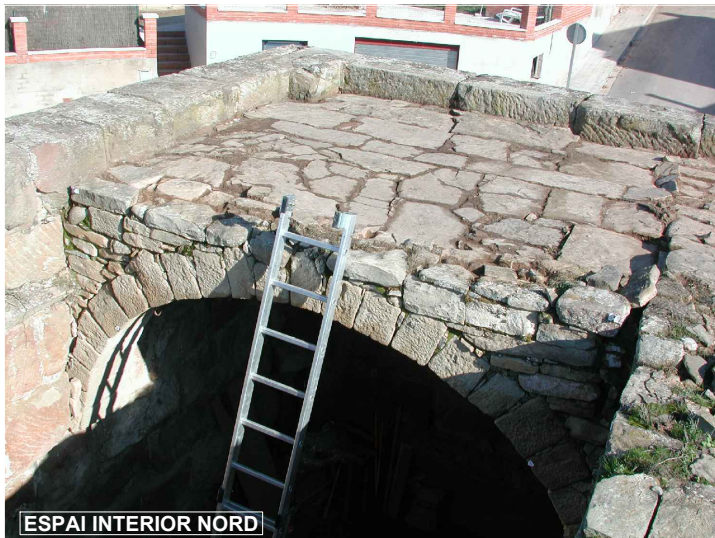
Vista de coronació del mur i volta espai Nord Font: SPAL-14/01/2003
