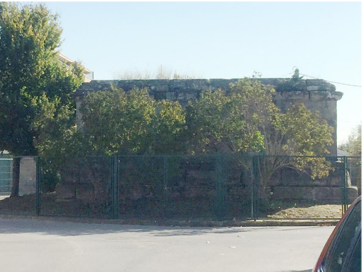
F3. Façana nord Font: GAA-16/11/2016
