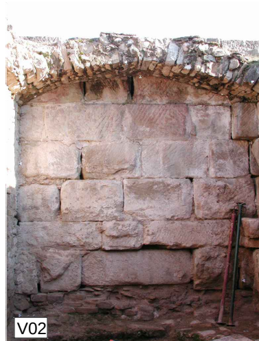
Cantonada interior façana Est
