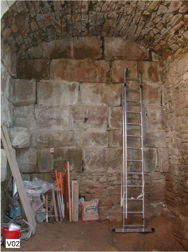
Façana interior façana Est Font: SPAL-14/01/2003
