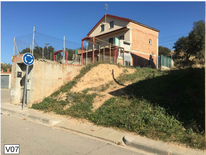
V07 Av. de Roma - Façanes pròximes Font: GAA-16/11/2016
