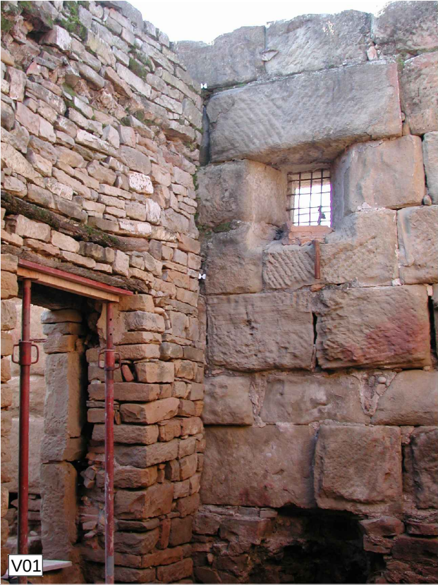
Cantonada interior façana Oest Font: SPAL-14/01/2003
