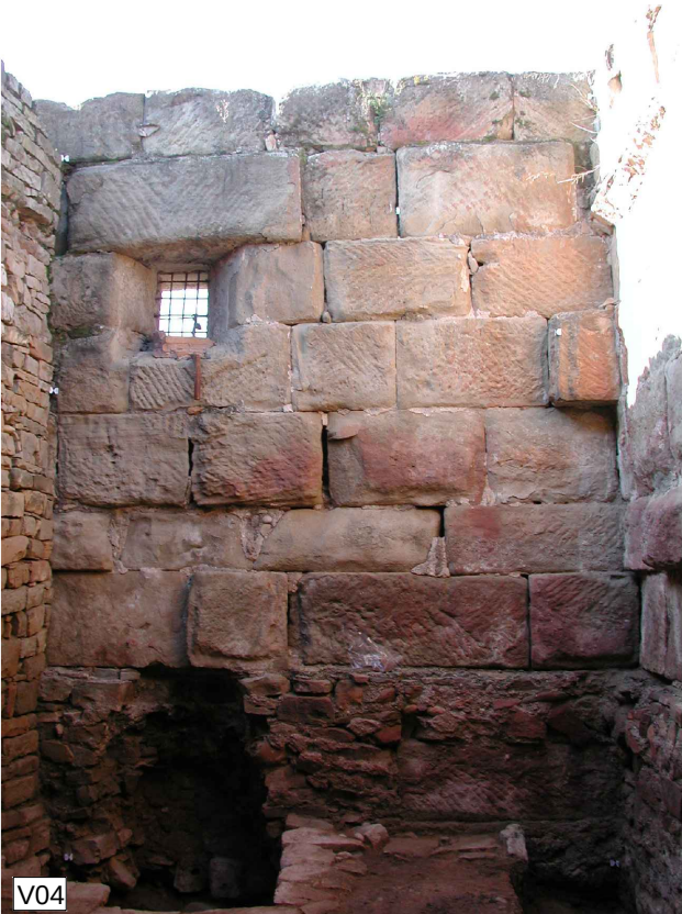
Façana interior façana Oest Font: SPAL-14/01/2003
