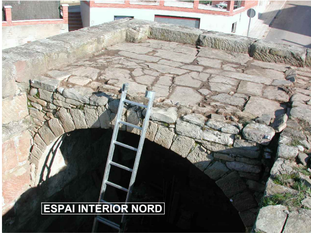
Vista de coronació del mur i volta espai Nord
