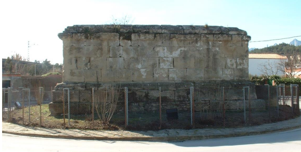
Façana de tramuntana. Avinguda de Roma. Font: GAA 22/02/2002
