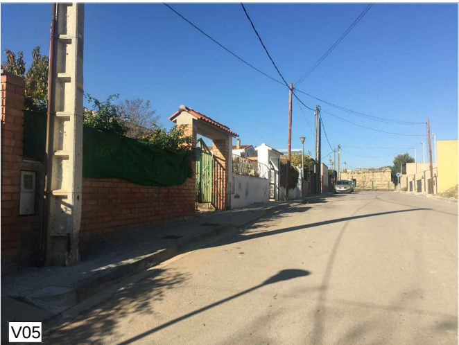
V05 Av. de Roma - Façanes pròximes Font: GAA-16/11/2016
