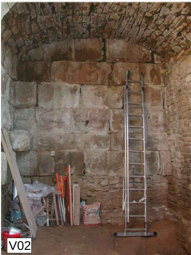
Façana interior façana Est
