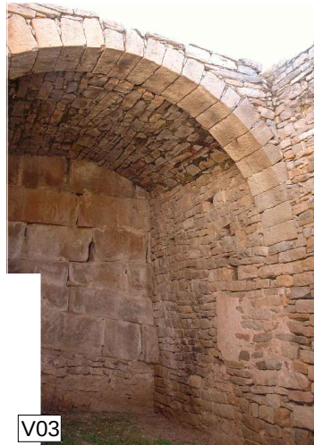
Cantonada interior façana Est
