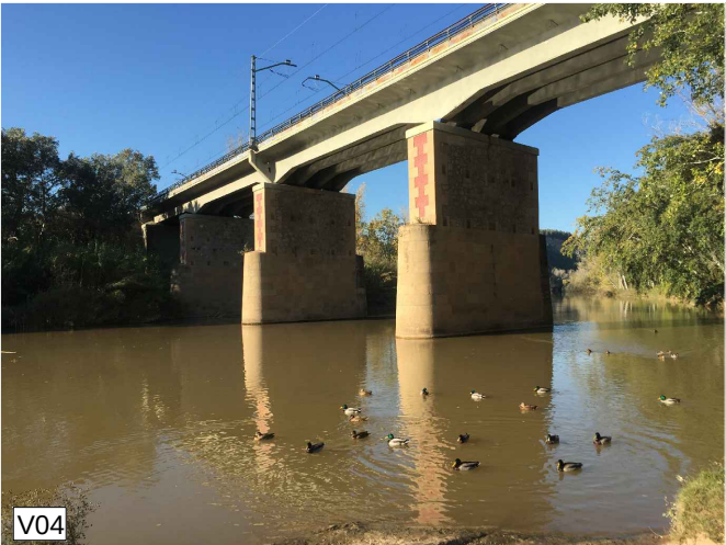
V04 Pont del Ferrocarril Font: GAA-16/11/2016
