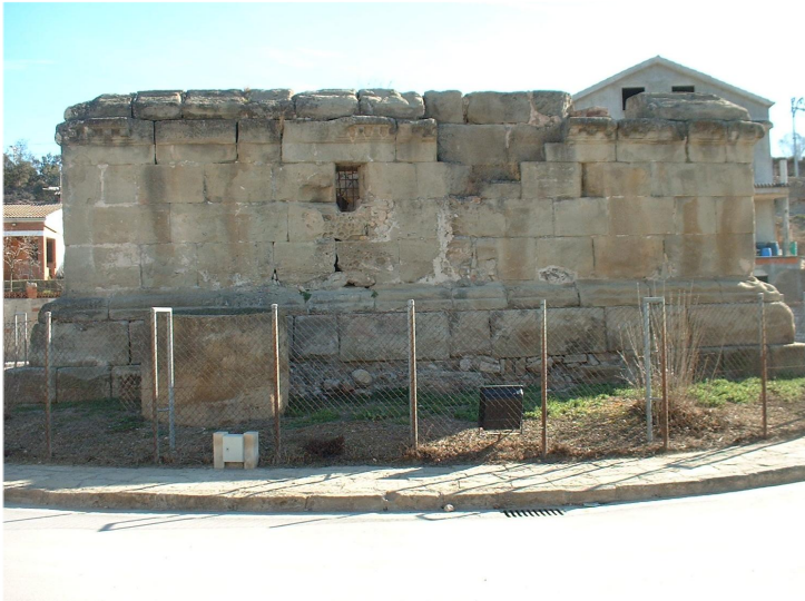
FAÇANA OEST FONT: SPAL-14/01/2003
