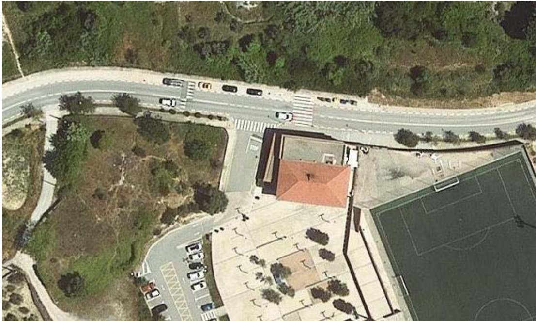
Imatge 1: Vista aèria de la coberta
