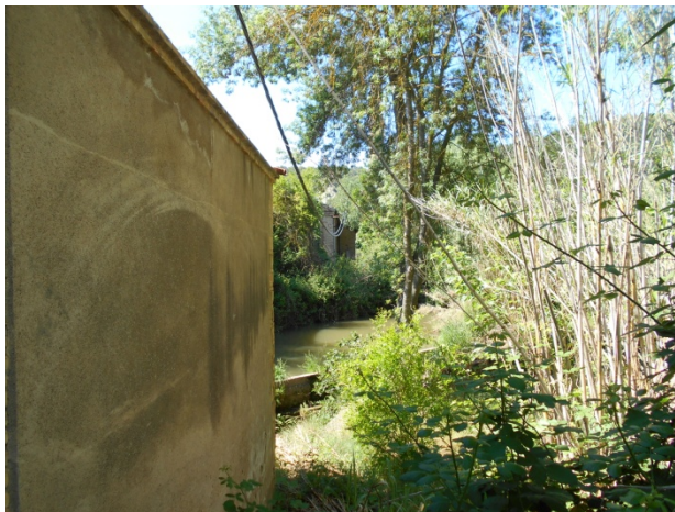
Imatge 9. Vegetació de ribera darrere de la minicentral hidroelèctrica.
