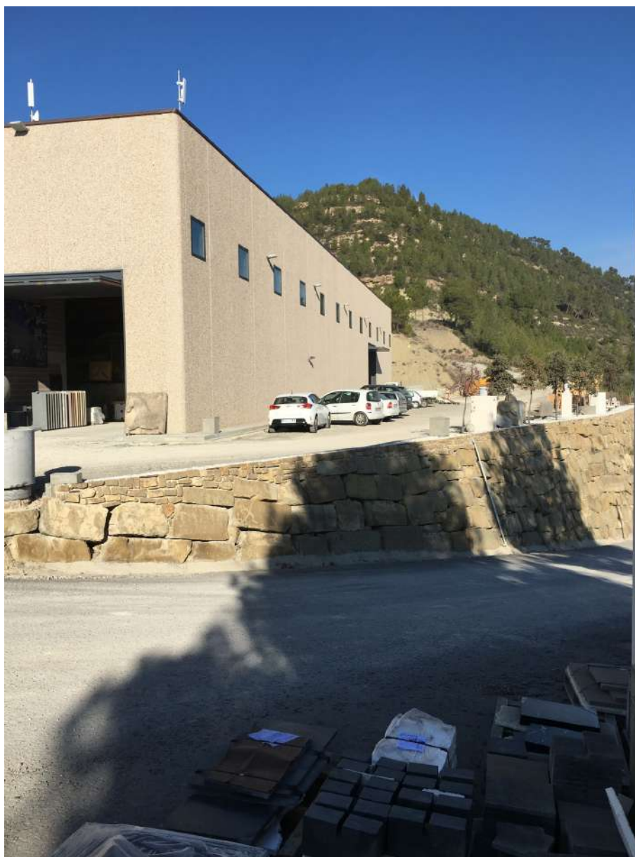
FOTOGRAFIA 2. VISIÓ DEL MUR DE CONTENCIÓ DE PEDRA D'ESCULLERA
