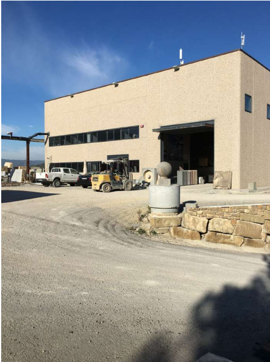
FOTOGRAFIA 1. VISIO DE LA NAU NOVA AMB L'ENTRONCAMENT DE LA PLATAFORMA DE L'ÀMBIT DEL PEU AMB EL MUR DE CONTENCIÓ
