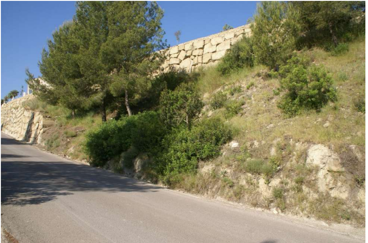
FOTOGRAFIA 3. VISIÓ DEL MUR DE CONTENCIÓ DES DEL CAMÍ D'ACCÉS
