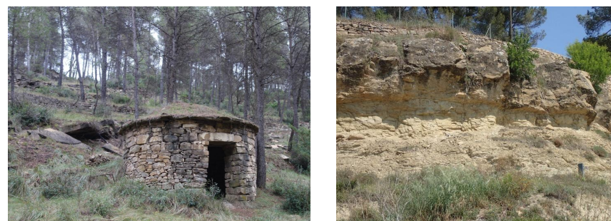
Fig. 10. Dreta: Alternança d'estrats de gresos, limolites i argil·lites, en un talús vora de la riera. Fig. 11. Esquerra: Esglaonament de feixes amb pedra seca i una barraca de vinya rehabilitada, de planta circular i volta construïda a mà amb blocs de gresos calcaris del mateix vessant.
