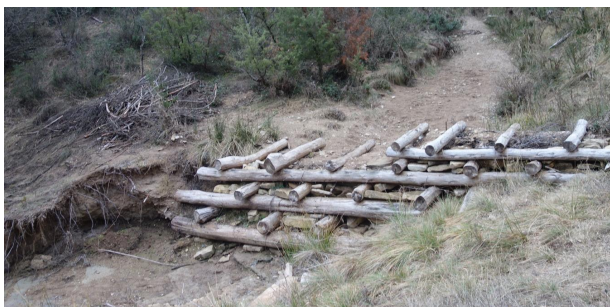
Fig. 37: Petit assut de bioenginyeria construït el 2022 a la riera de Castellet. Foto gener 2024.
