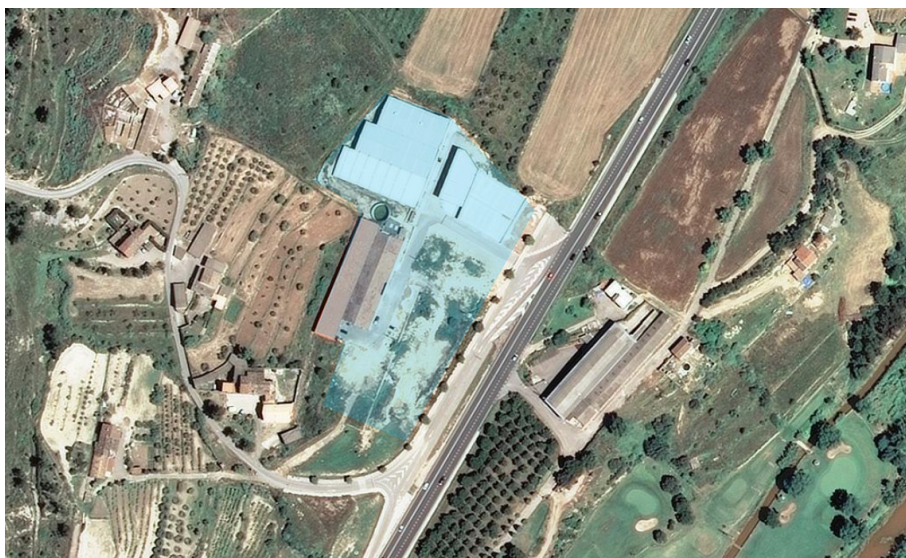
Any 2009, amb una tercera edificació construïda a la parcel.la 5.
