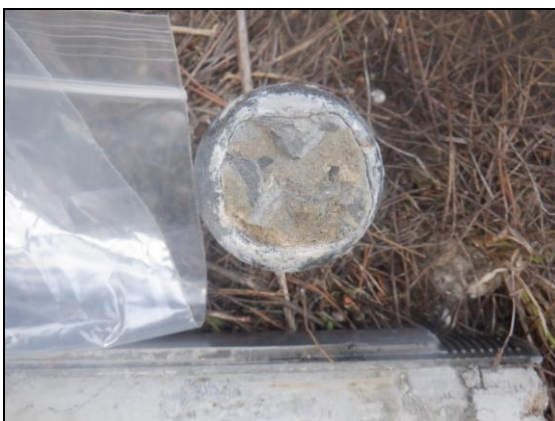
Foto 23: Sondeig S-11, boca SPT a 1,6 metres.
