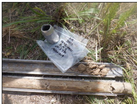
Foto 34: Sondeig S-15, SPT a 2,9 metres.
