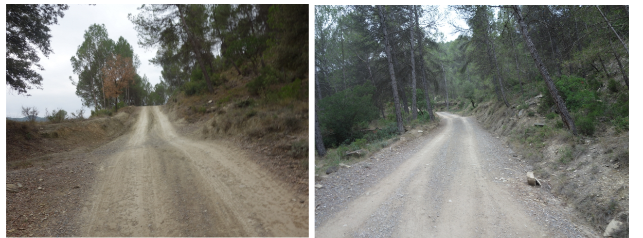
Esquerra: Camí rural al nord de Casassaias. Dreta: camí rural a l'est de Cal Ponç. Alguns trams amb subbase, cunetes i trencaaigües en general ben mantinguts (gener 2024)
