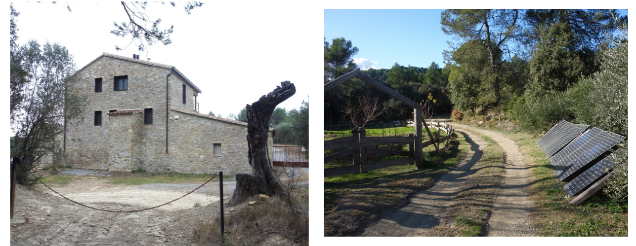
Esquerra: Accés a Cal Ponç des del camí rural , a la cruïlla del camí de Santa Margarida. Dreta: Accés principal a Casassaias; des del camí rural estructurador que connecta Castellgalí amb la carretera BP-1101 (color verd en el mapa anterior).
