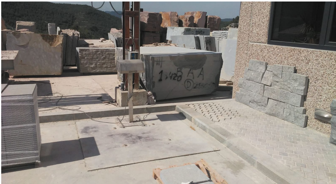
IMATGE DE L'ACCÉS A LA DEPURADORA AUTÒNOMA DEL PEU
