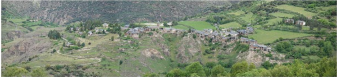
Façana sud del nucli de Tírvia
