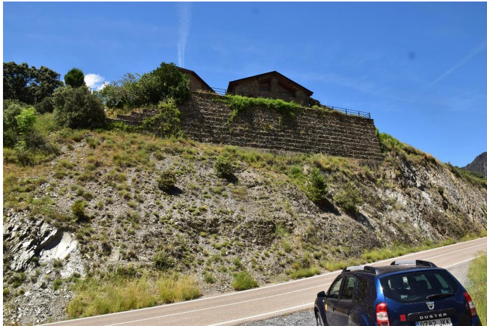
Fotografia 7: Vista del talús de la carretera L-504, a la base del qual es veuen dipòsits d'acumulació de petites caigudes.
