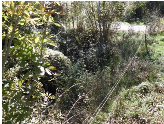
Figura 6. Imatge de la llera del torrent Innominat, aigües amunt del creuament amb la carretera L-504.
