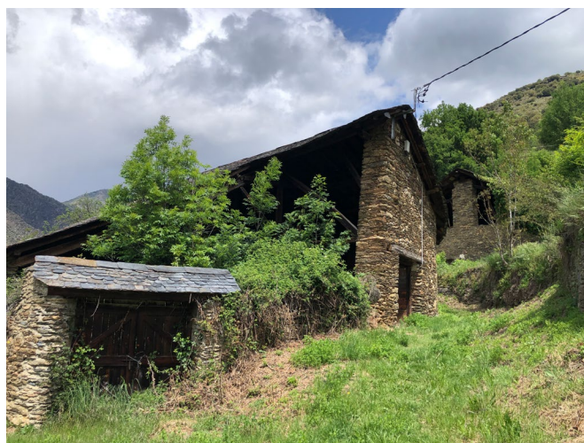
Imatge de les edificacions agràries objecte de cessió
