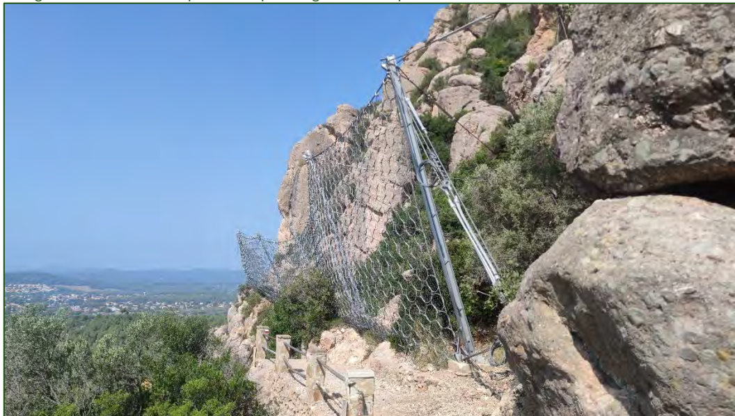
Fotografies 19: Malla de protecció per caiguda de roques. Punt 1. Font: ACC 2024.
