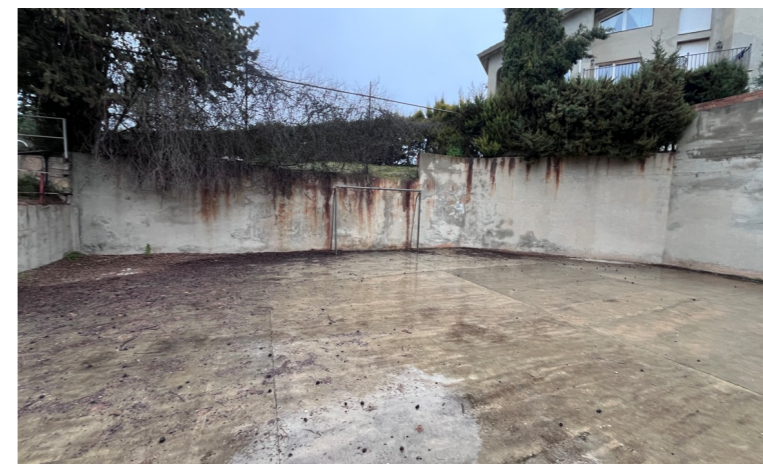
Pista. Vista vers el nord-oest
