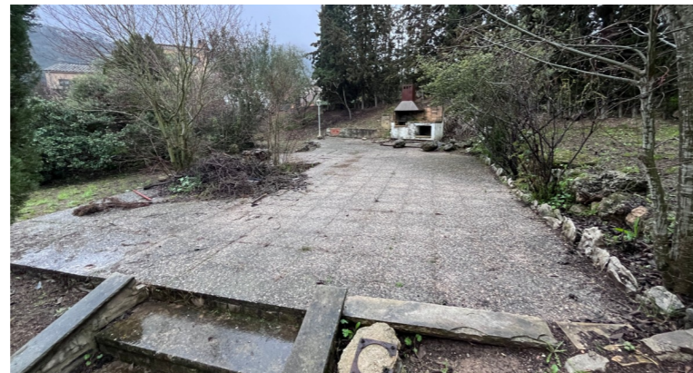
Zona pavimentada de la barbacoa
