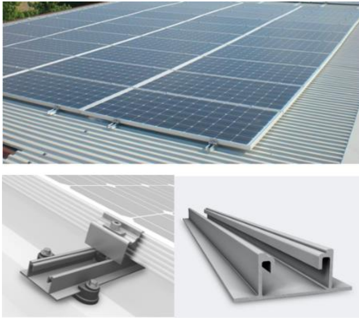
Figura 5.- Detall instal·lació de perfils i panells fotovoltaics.
