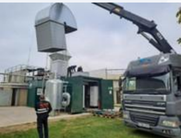
Instal·lació sistema filtració / refrigeració cogeneració 360 kW
