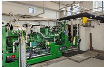
Instal·lació nou motor 2G 160 kW i caldereria
