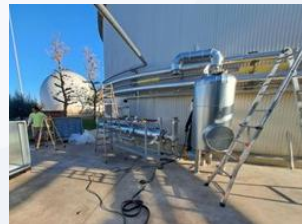
Instal·lació nou motor 2G 160 kW i caldereria
