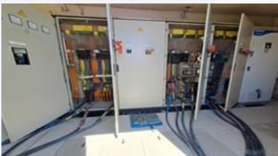
Substitució interruptors CTT1
