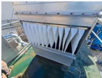
Instal·lació sistema filtració / refrigeració cogeneració 360 kW
