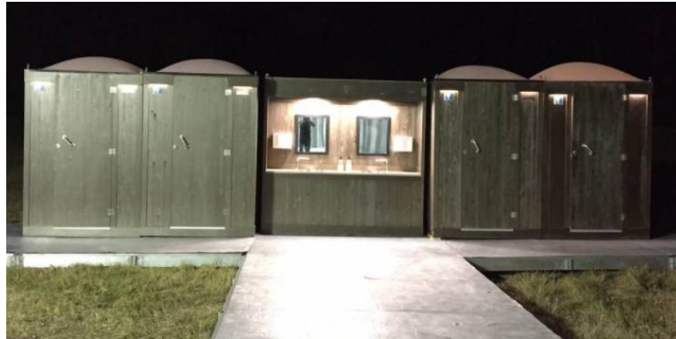
Instal·lació de banys prefabricats. Vàter, lavabo i dutxes.
