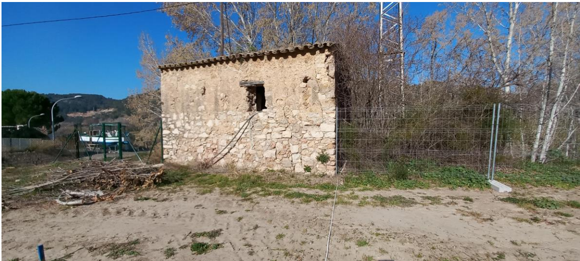
11 ANTIGA CASETA DE CONTROL DEL PAS DE BARCA. Fora de l'àmbit.
