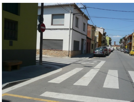
Imatge 55. Línia d'estop ben marcada i alineada amb l'aparcament. Carrer de Paral·lel sortint de Josep Maria de Sagarra.
