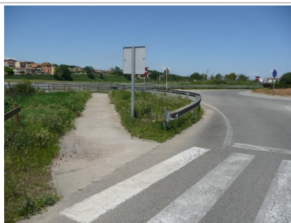
Imatge 109. Vista del camí i de l'anella de la rotonda.
