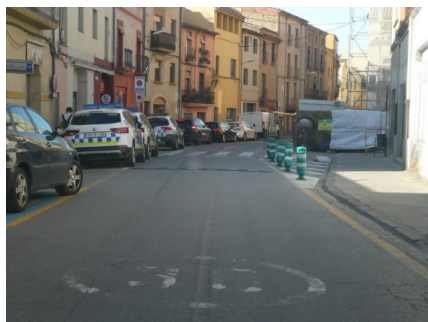
Imatge 53. Cal repintar marques. Carrer Cavallers, en obres.
