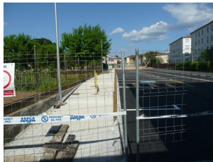
Imatge 41. Millora de la mobilitat a peu dins del pàrquing amb vorera pavimentada.
