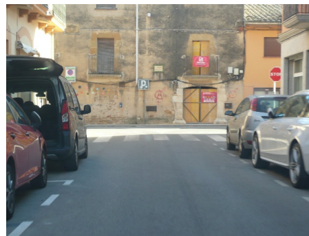
Imatge 75. Visibilitat deficient per aparcament legal i irregular al carrer de l'Amor Filial.
