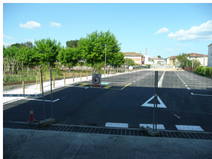
Imatge 40. Tanques d'obra amb el pàrquing encara no obert.
