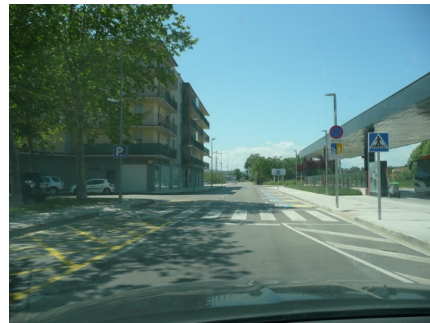
Imatge 68. Orella i graella per a evitar aparcament i millorar la visibilitat al pas de vianants. Junt a l'estació d'autobusos.
