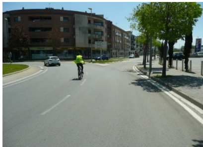
Imatge 89. Vegeu embocament de la sortida i radi obert. Senyal P-20 oculta.
