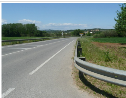
Imatge 122. Vista del conductor cap a ramal oest.
