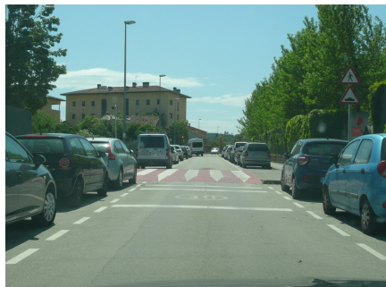
Imatge 82. C. del Raig. Pas en plataforma reductora.
