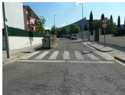
Imatge 26. Vegeu que l'ample de circulació és de fins a 5 m d'ample.
