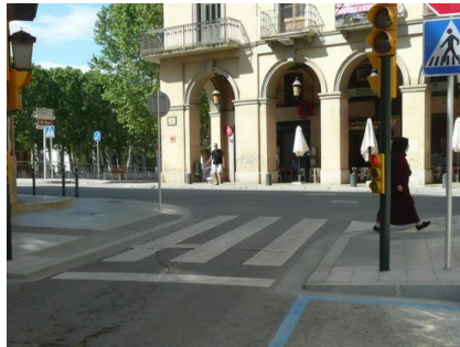
Imatge 3. Orelles i millor accessibilitat del pas de vianants.
