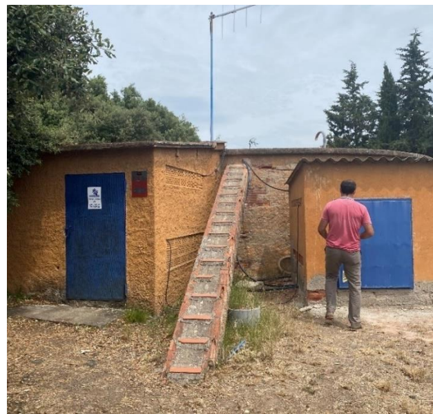
Figura 43 - Dipòsit Can Villa.
