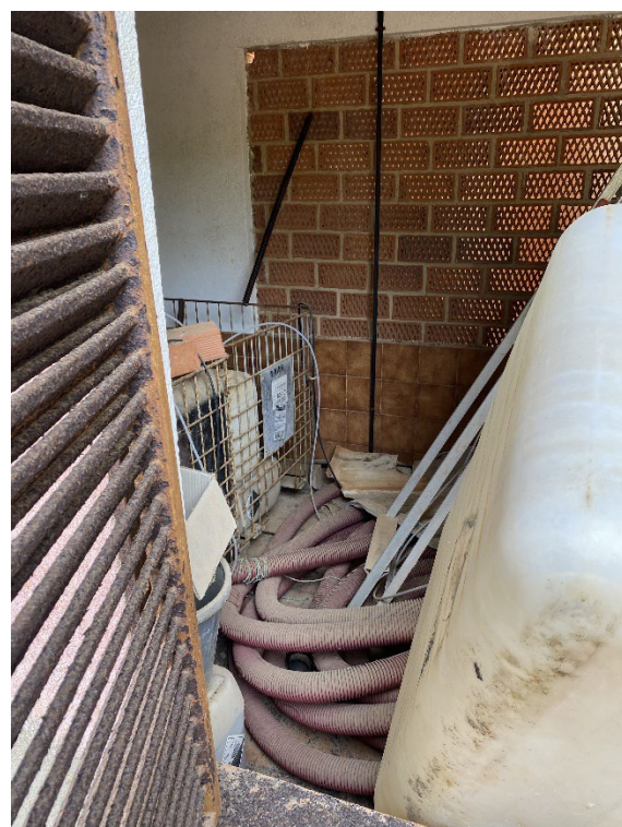
Figura 86. ETAP urbanització Residencial Parc.
