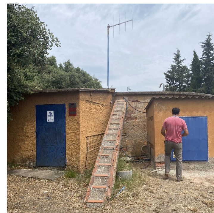
Figura 64. Dipòsit Can Villa.
