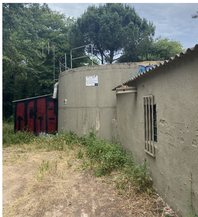
Figura 48. Dipòsit Receptor i Estació Elevació Zona Esportiva.
