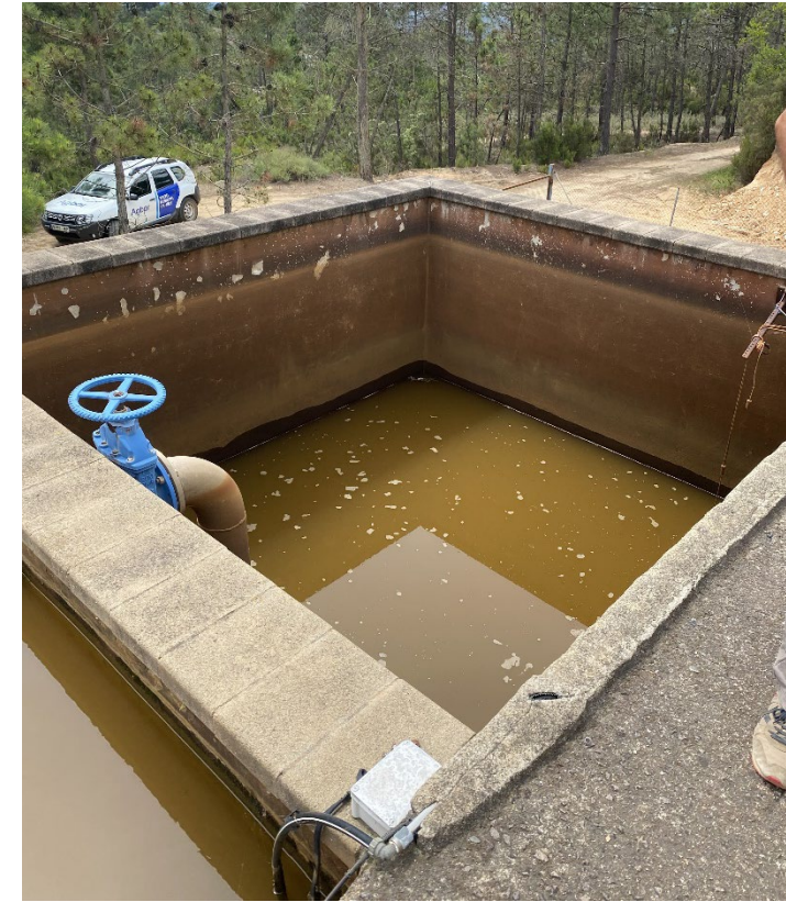
Figura 83. ETAP urbanització Residencial Parc.
