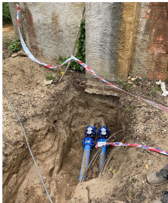
Figura 74. Entrada d'aigua a la EB.
