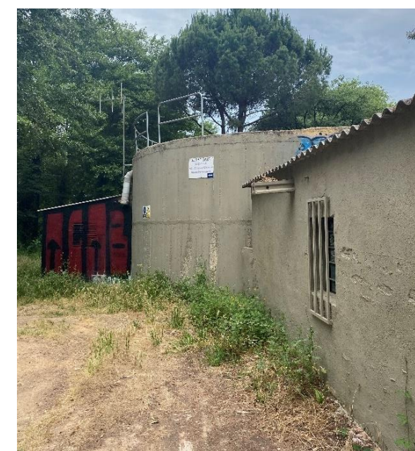
Figura 19 - Dipòsit Receptor i Estació Elevació Zona Esportiva.
