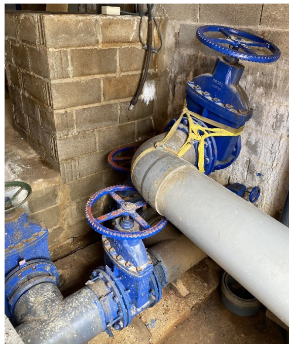
Figura 78. ETAP urbanització Residencial Parc.
