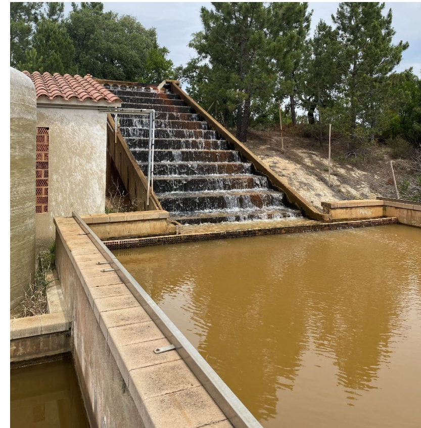
Figura 79. ETAP urbanització Residencial Parc.
