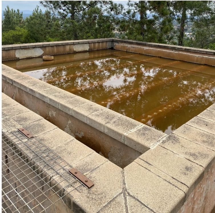
Figura 81. ETAP urbanització Residencial Parc.
