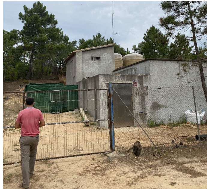
Figura 77. ETAP urbanització Residencial Parc.
