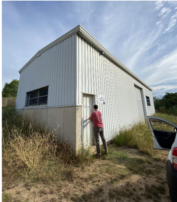
Figura 27. ETAP i Dipòsit Intermig.
