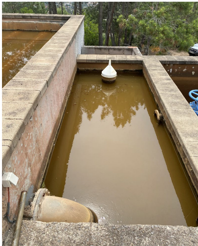
Figura 82. ETAP urbanització Residencial Parc.
