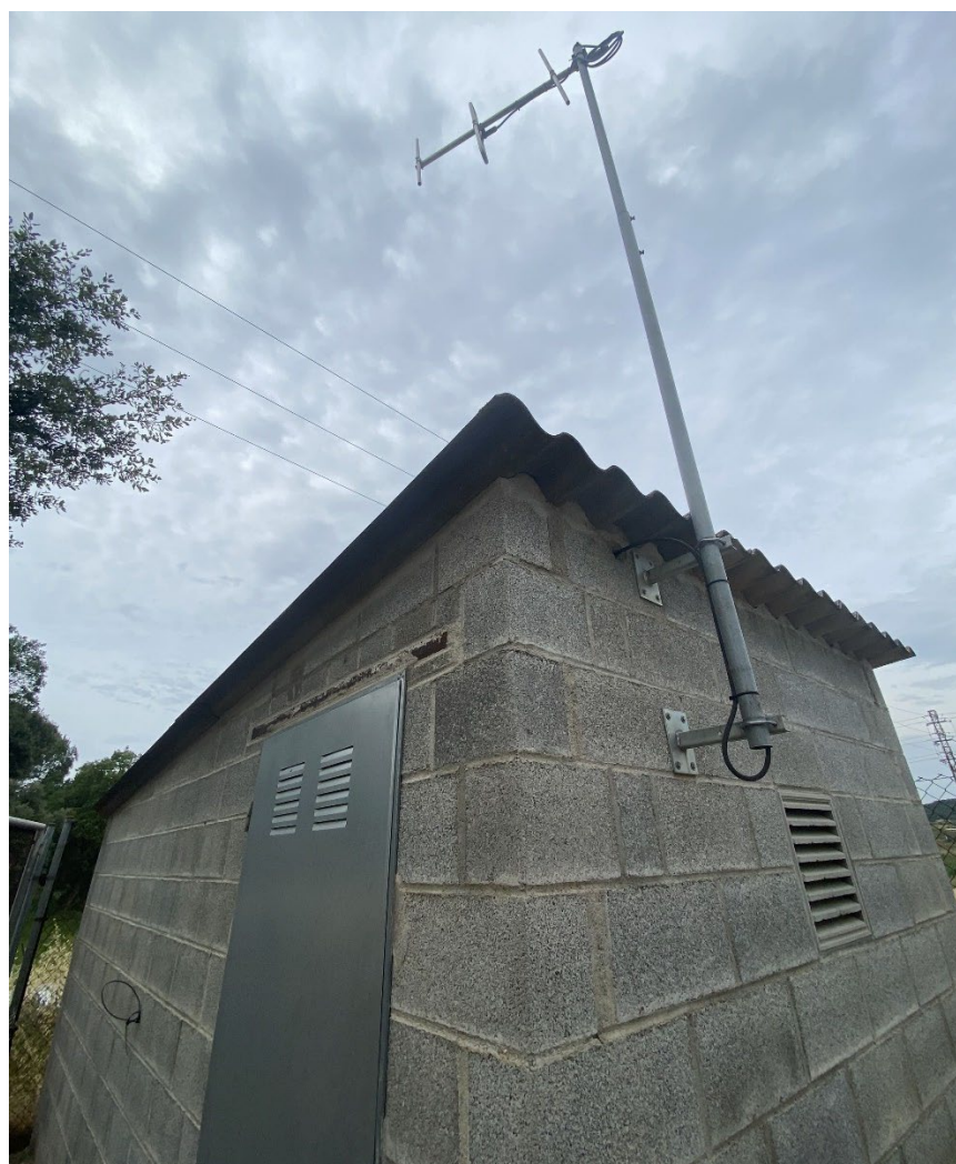
Figura 70. Estació acceleradora Can Picó.
