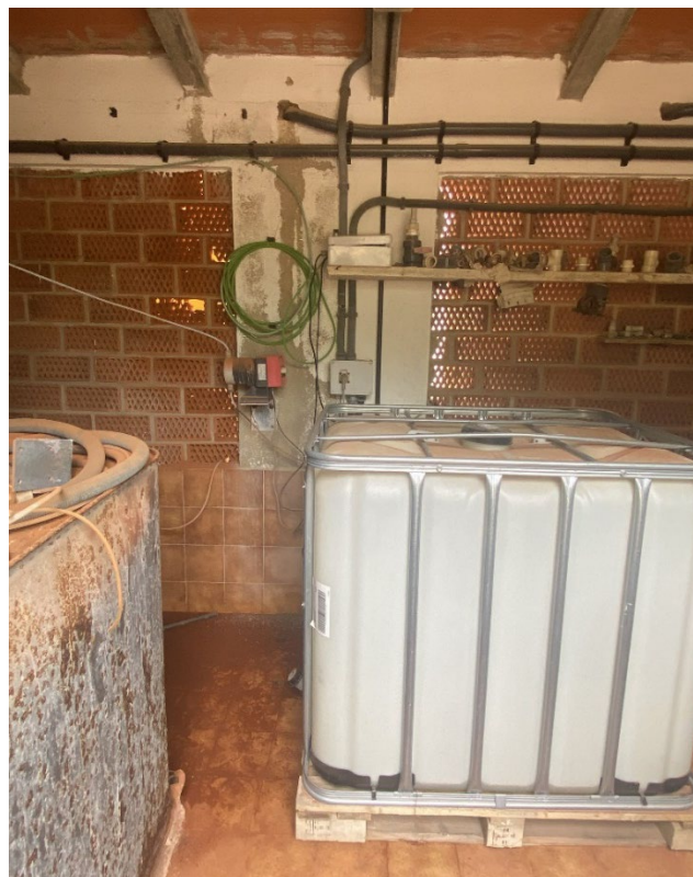
Figura 85. ETAP urbanització Residencial Parc.
