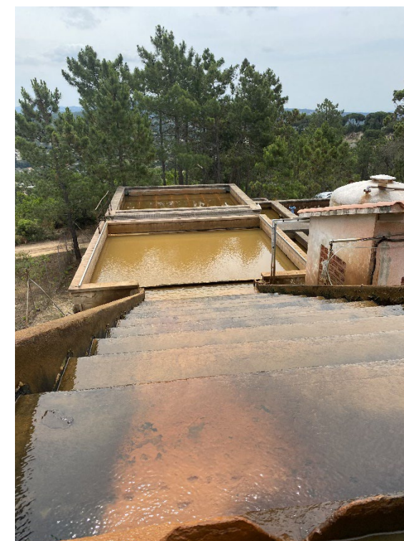
Figura 80. ETAP urbanització Residencial Parc.
