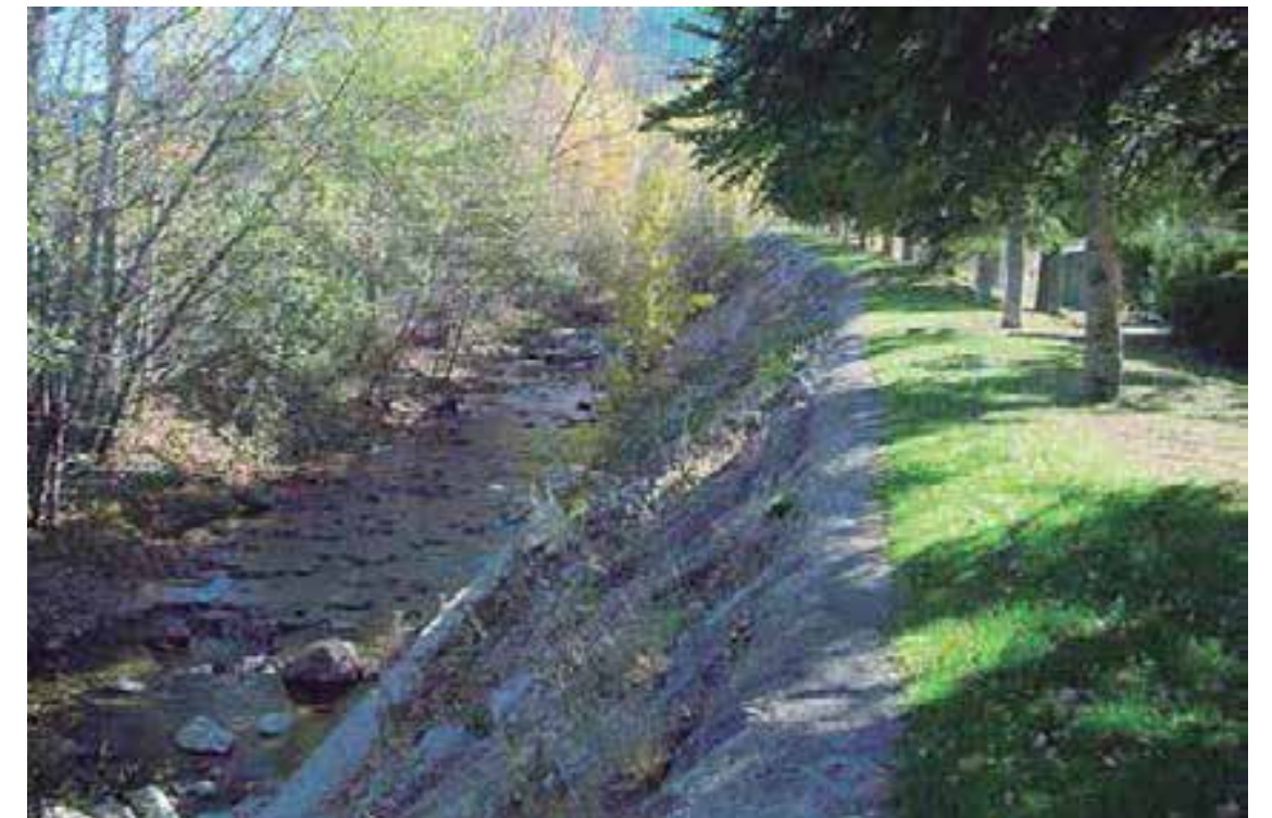
Fotografía núm. 8 : Vista del talud protegido de la margen izquierda, delante de la zona de estudio.
