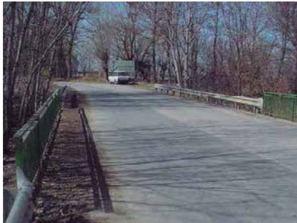
Fotografía núm. 2 : Vista superior del tablero del puente de la carretera local (avenida Girona). A la izquierda se emplaza la zona en estudio.
