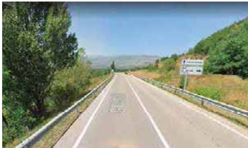
Fig. 26: Carretera GIV-4082. Font: AIM, elaboració pròpia
