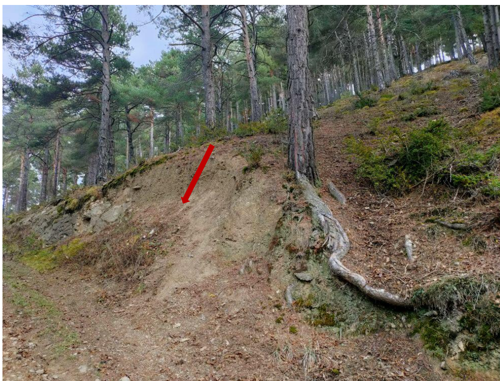
Fotografia 2: Eslavissada en un talús de la zona del Bosquet. S'observa superfície de lliscament planar en lutites i gresos.
