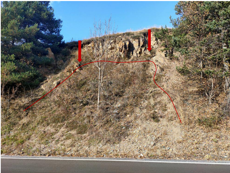
Fotografia 14: Esllavissada en un talús rocallós del l'avinguda d'Alp. S'observen una superfície de lliscament en roca, amb dipòsits al peu, i la caiguda de blocs, de fins a alguns centímetres de diàmetre.
