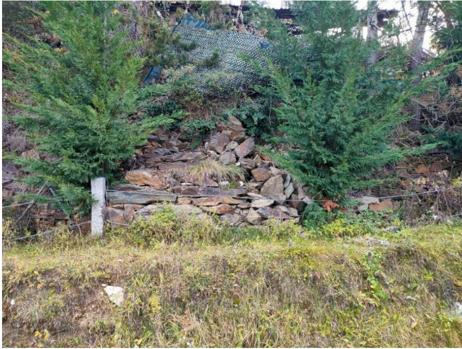
Fotografia 24: Esllavissada recent en un mur de rocalla en el carrer del Coll Siser
