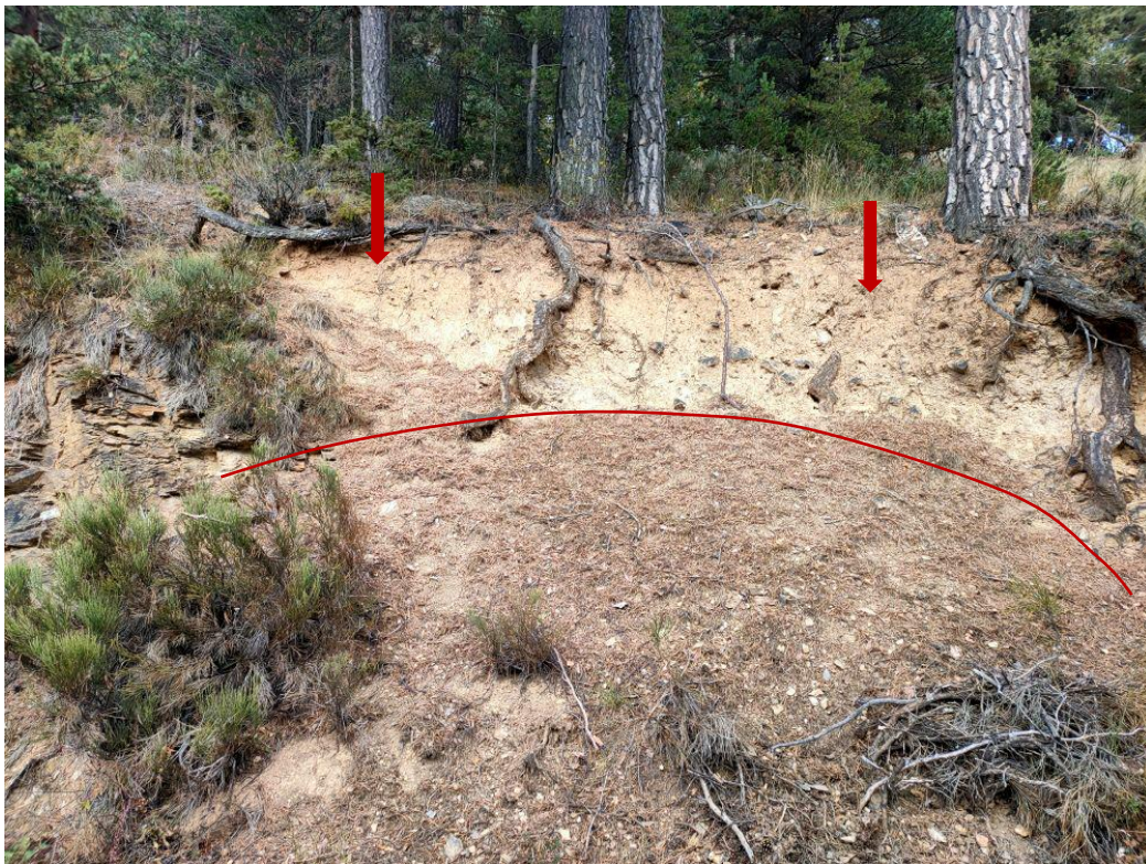
Fotografia 18: Esllavissada recent en un talús en el carrer de la Perdiu. S'observa una superfície de lliscament en sòls, amb dipòsits al peu formats per sorres.
