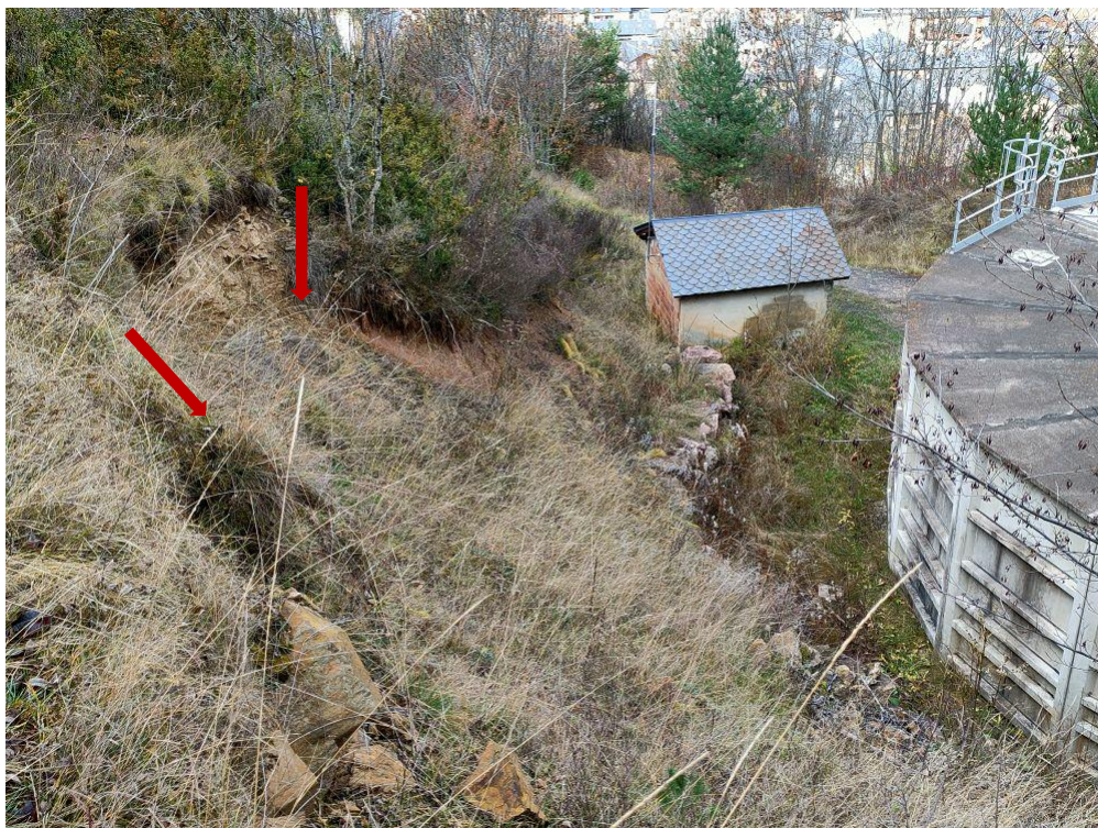
Fotografia 1: Eslavissada recent en un talús per sobre el dipòsit d'aigua, estabilitzada amb mur escullera. S'observen superfícies de lliscament planar en lutites.
