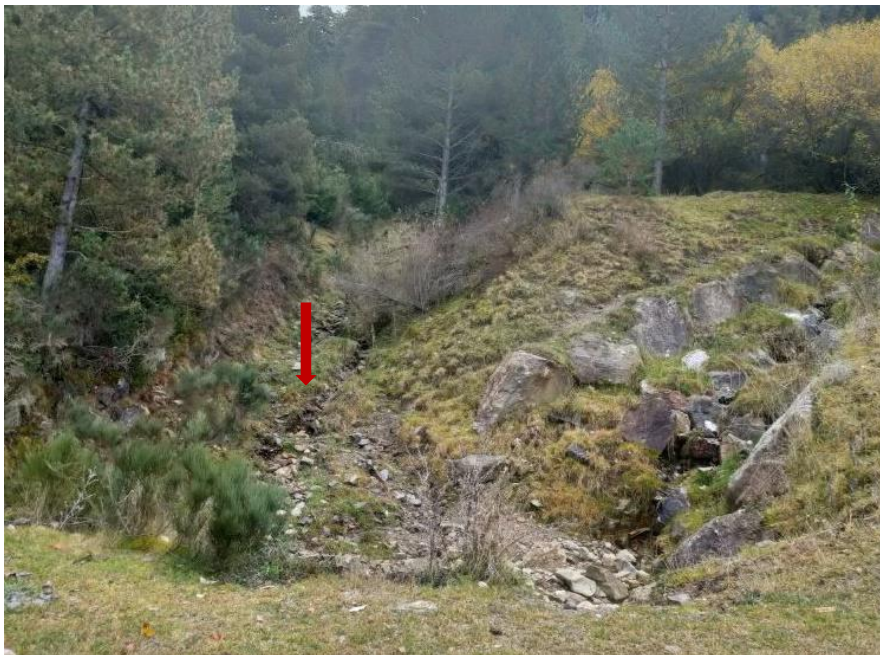
Fotografia 11: Acumulació d'arrossegalls del torrent en la zona de canalització de pas per el carrer de l'avinguda de la Molina.
