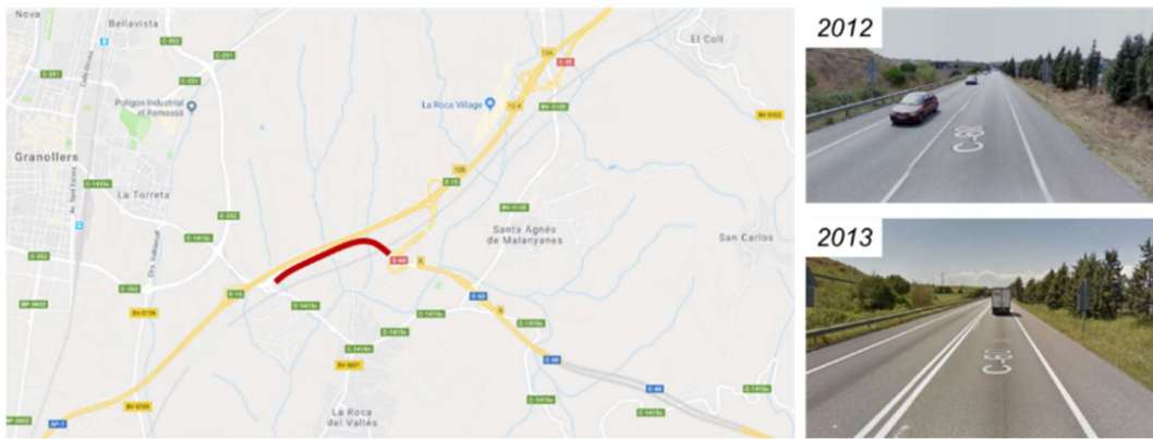
Figura 76. Tram C-60 entre AP-7 i C-1415c. Punt de l'actuació al 2012 i 2013
