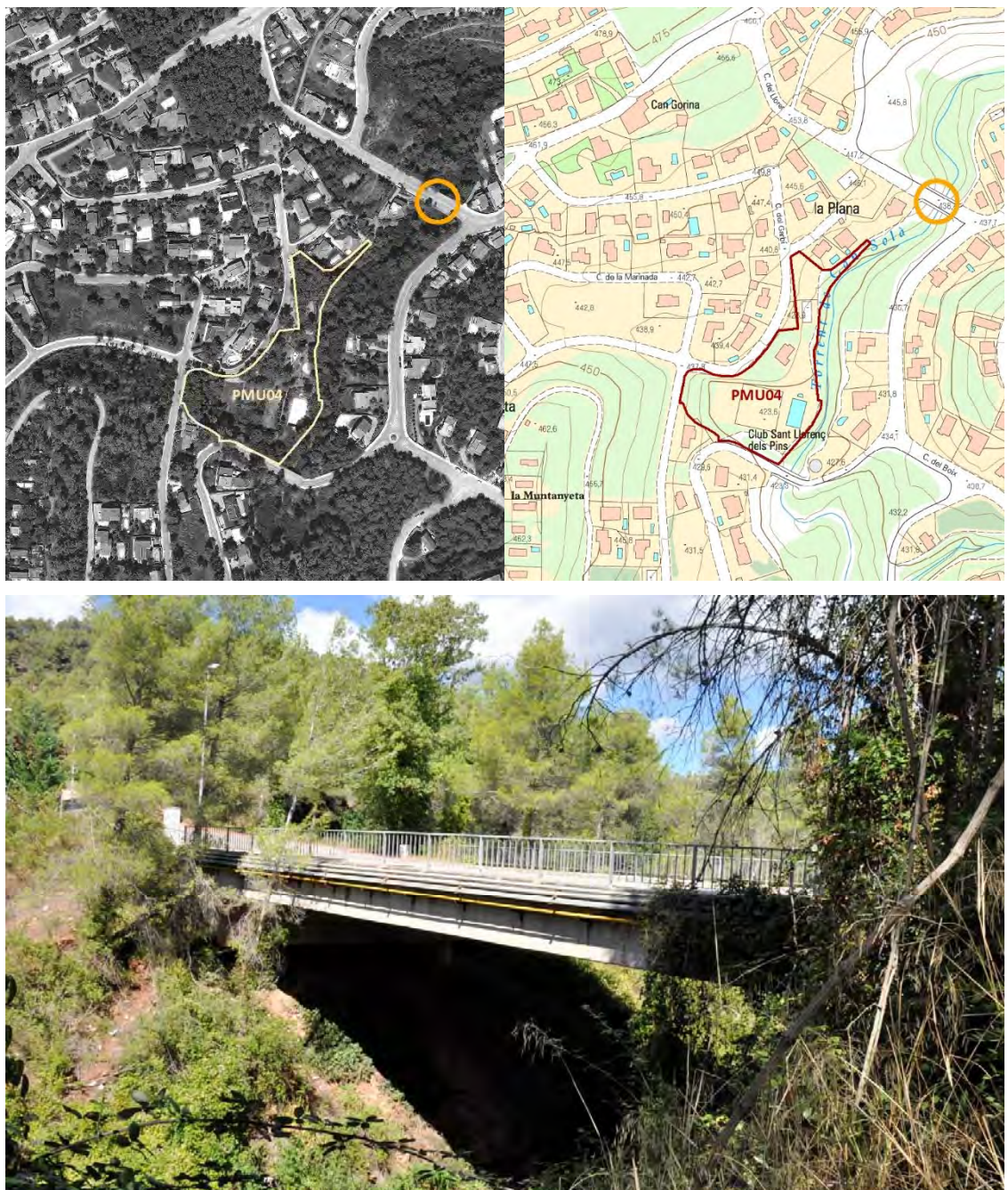
Figura 3. Ubicació i vista des d'aigua avall de l'obra de pas existent corresponent al carrer del Llorer.
