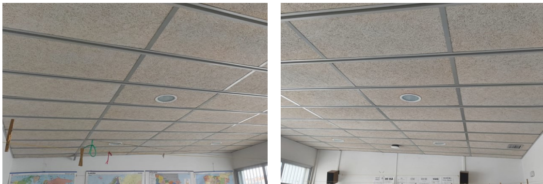
Fotografia n°4 – Aula tipus, planta primera, escola Torredemer (Primària).
