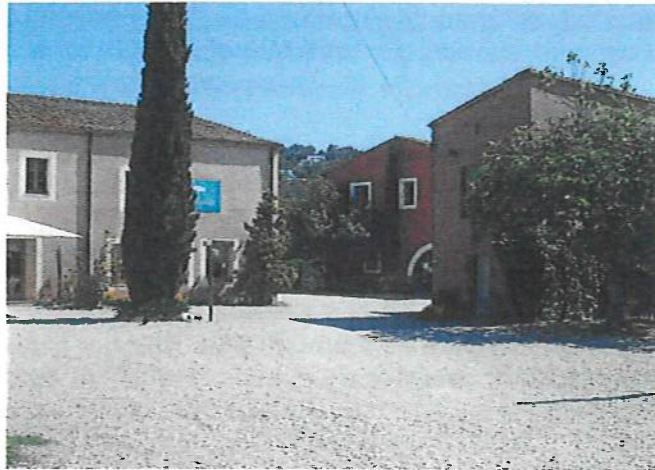
Fotografia 1: vista del conjunt de les edificacions
