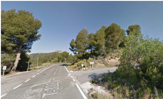
Accés existent de la planta d'extracció i tractament d'àrids.
