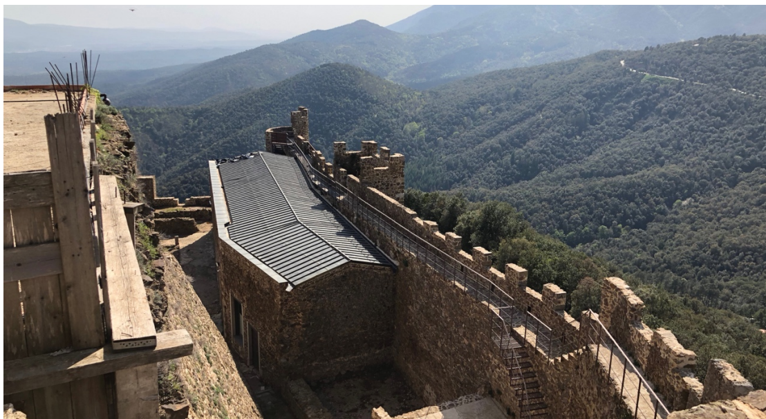
Imatge 30: Edificis restaurats al pati d'armes
