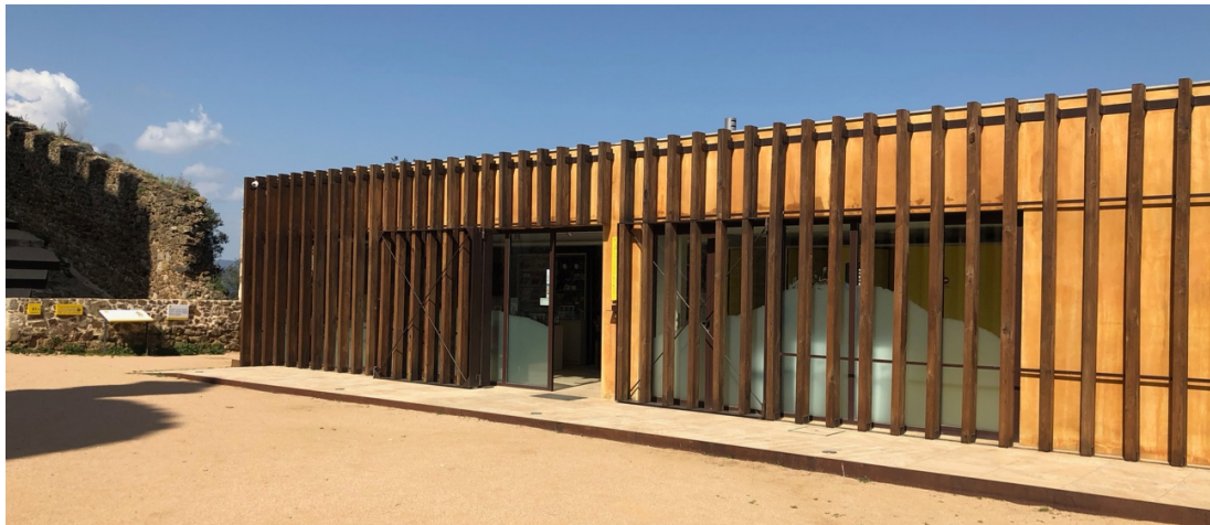
Imatge 29: Edifici de serveis al recinte jussà
