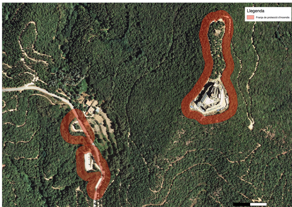
Imatge 42: Franja de protecció d'incendis de 25 metres
