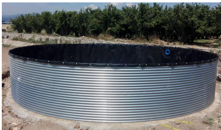
Imatge d'un dipòsit metàl·lic similar al que trobem instal·lat al Pla de Talavera.
