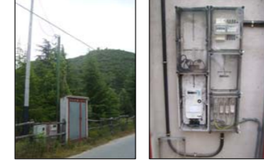
3. CASITA D'OBRA Dipòsit d'aigua (Ref. DC 1000) capacitat 1095l diàmetre 1,14m i alt 1,36m Bomba (Lowara) Comandaments elèctrics - diferencial general
