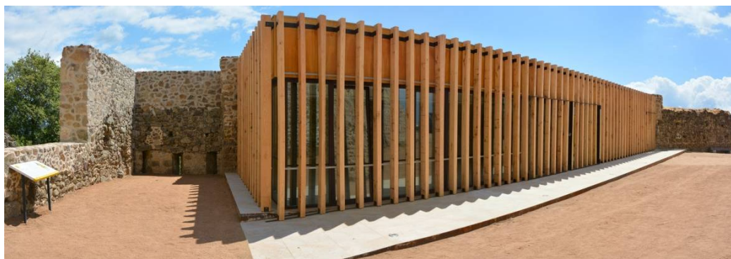
Fig. B14. Imatge de l'edifici de serveis, adequadament integrat en el pany de muralla en què es recolza.
