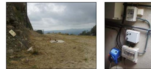
5. SALA SOTERRADA Dipòsit d'aigua de políester (Remosa) Registre sanitari: 39-0485/CAT Model Ind. Núm 120904 Ministeri de Sanitat: 39.021128 Bomba (MUT) 38 d) Comandaments elèctrics
