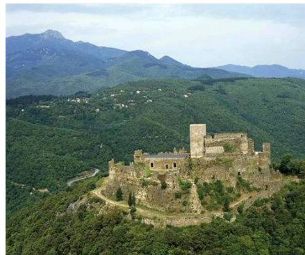
Fig. B12. Imatge del conjunt acabada la 2a. fase
