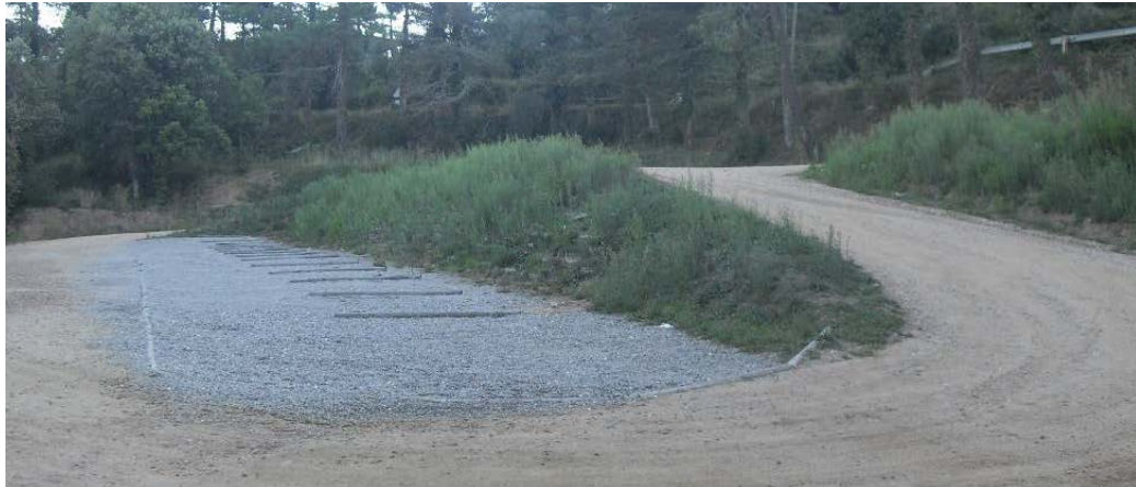
Fig. D7, D8 i D9. Imatges de l'aparcament de vehicles situat en un pla inferior al de la carretera.
