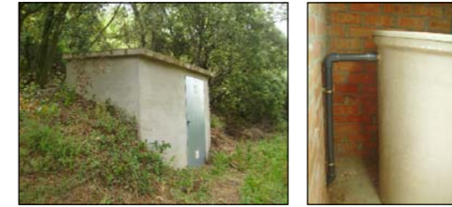
3. CASITA D'OBRA Dipòsit d'aigua (Ref. DC 1000) capacitat 1095l diàmetre 1,14m i alt 1,36m Bomba (Lowara) Comandaments elèctrics - diferencial general
