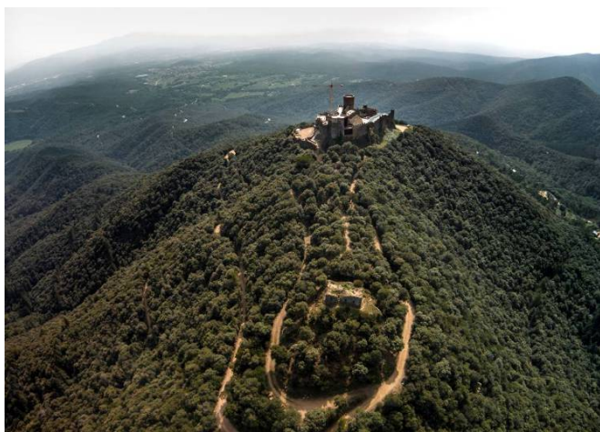
Fig. B11. La Torre i, al fons, el Castell.
