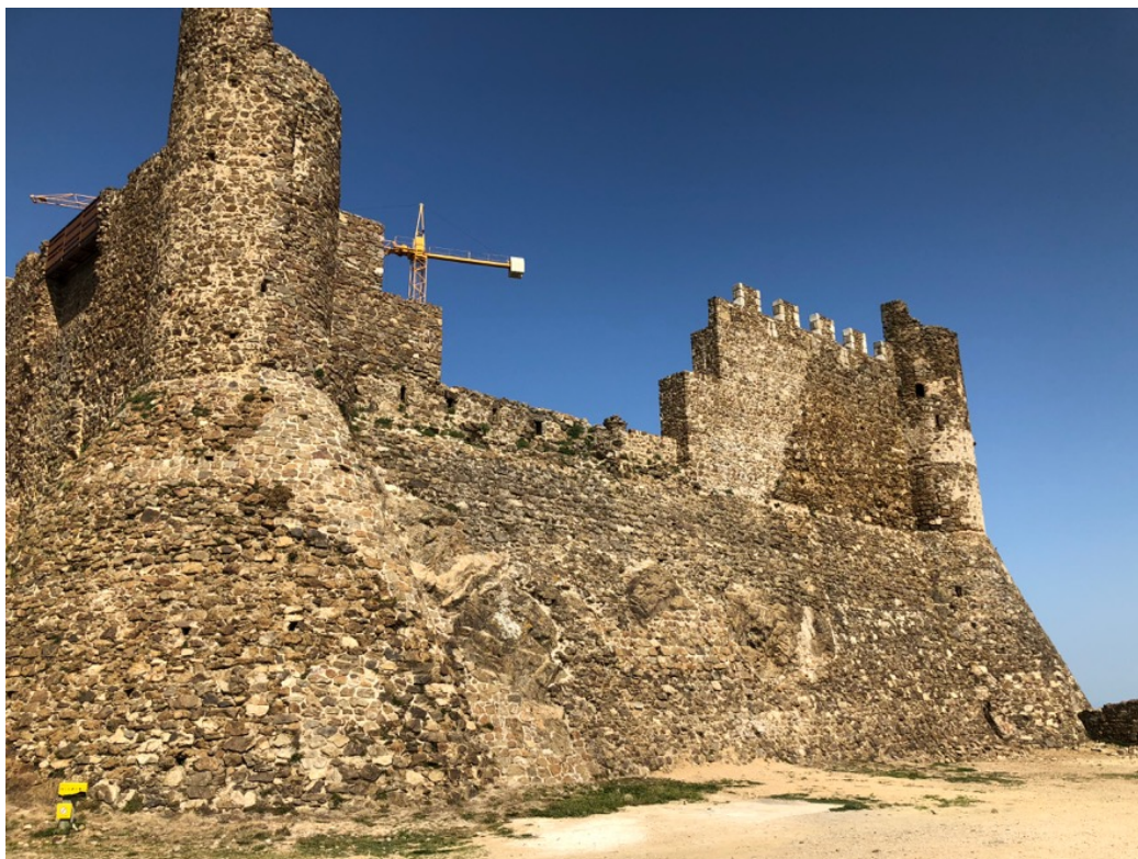
Imatge 2: Muralla oest en procés de restauració
