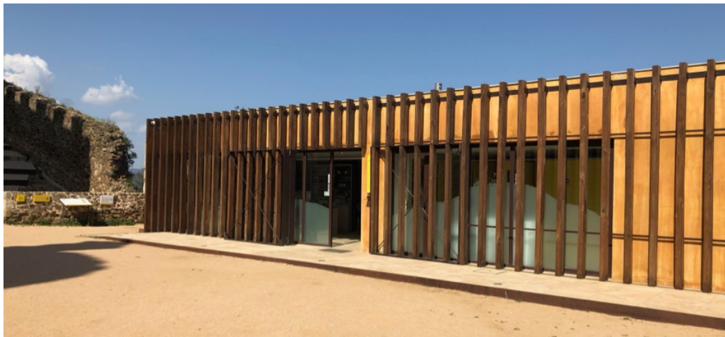
Imatge 14: Edifici de serveis
