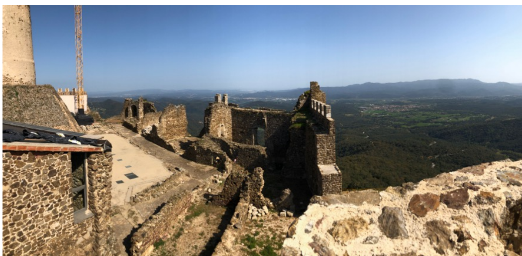
Imatge 15: Pati d'armes en procés de restauració
