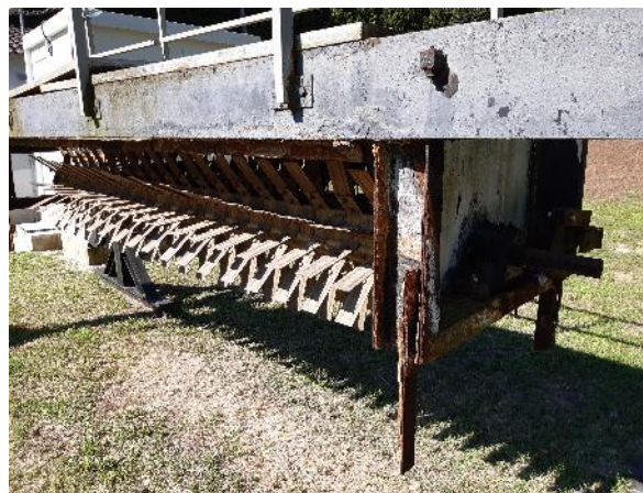
Il·lustració 2: Imatges de l'estat de les estructures dels rotors, totalment oxidats i en mal estat.
