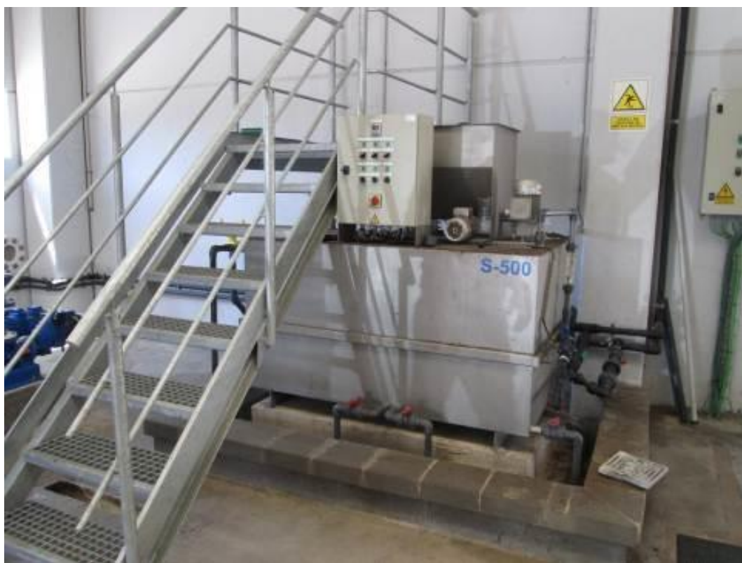
Preparador de polielectròlit de l'EDAR de Can Massuet – El Far
