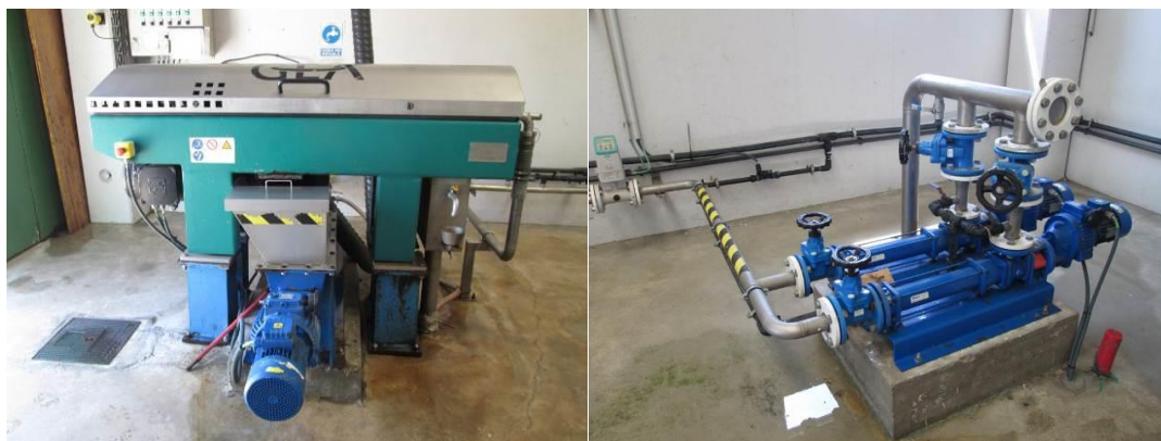
Centrífuga i bombes de fang de l'EDAR de Can Massuet – El Far
