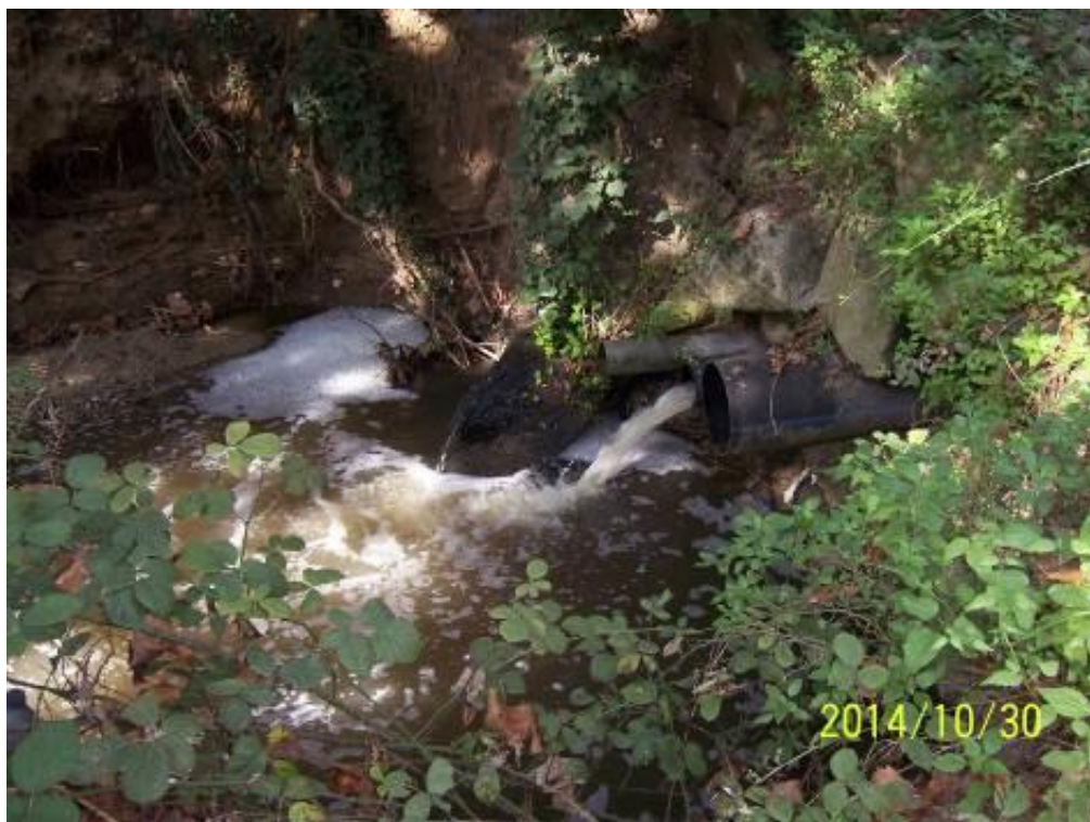
Tapes exteriors sobreeixidor de d'EB Principal (Can Massuet – El Far). L'aigua que surt correspon a la sortida de l'EDAR.
