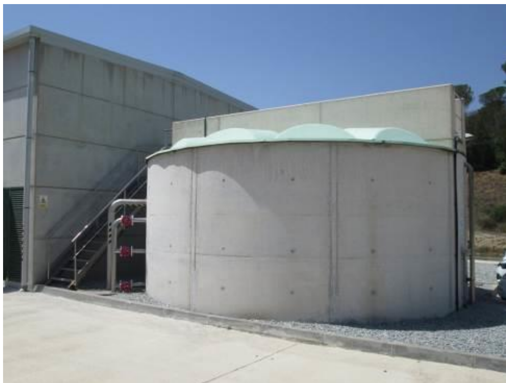
Espessidor de l'EDAR de Can Massuet – El Far
