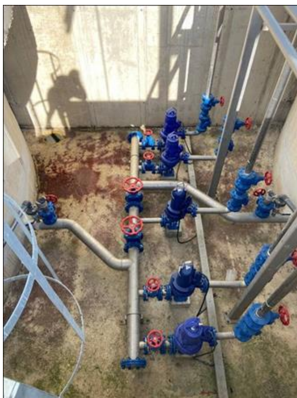
Joc de bombes de recirculació i purga en cambra seca de l'EDAR de Can Massuet – El Far
