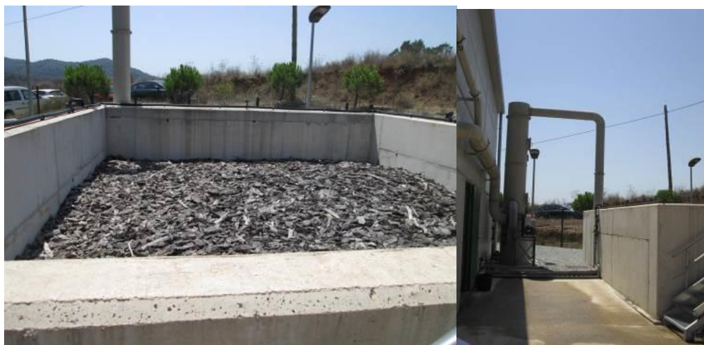
Sistema de desodorització biològic i químic de l'EDAR de Can Massuet – El Far
