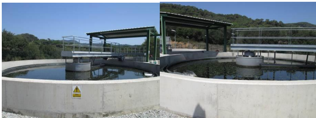
Decantador 1 i 2 de l'EDAR de Can Massuet – El far
