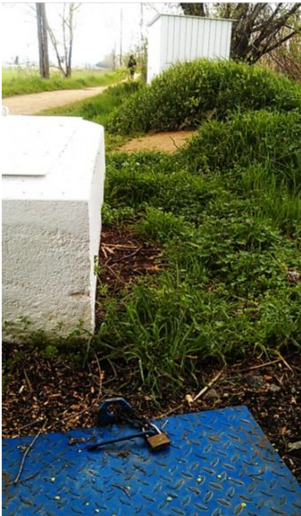
Vàlvula de descàrrega
