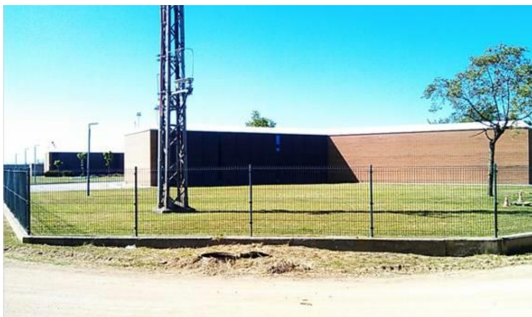
Ubicació vàlvula d'aïllament
