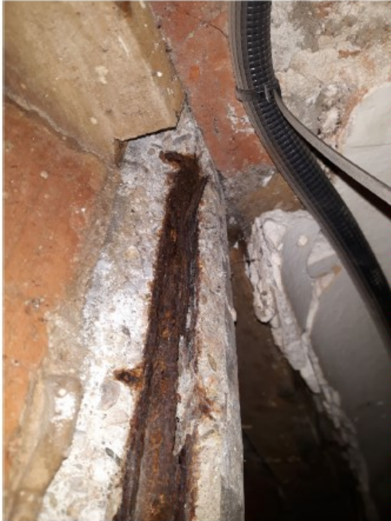
FOTO 2.- La part inferior de la biga hi manca totalment. L'armadura totalment rovellada. Zona propera al recotzament de la bigueta.
