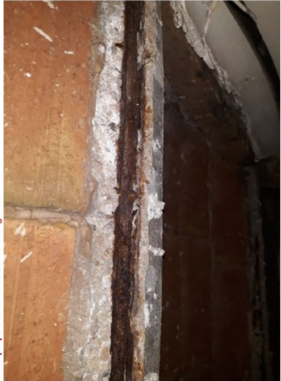
FOTO 2.- La part inferior de la biga hi manca totalment. L'armadura totalment rovellada. Zona propera al recotzament de la bigueta.
