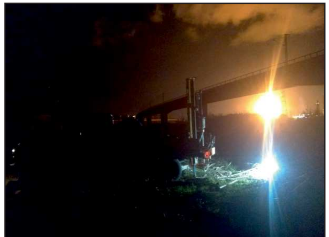
Emplaçament del penetròmetre P-1.
