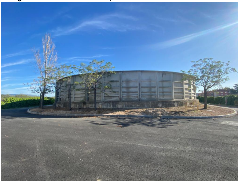
Fotografia 4. Vista exterior del dipòsit 1.
