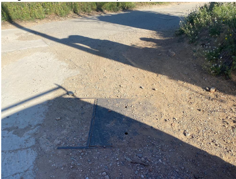
Fotografia 2. Vista exterior de la captació del pou de les afores.
