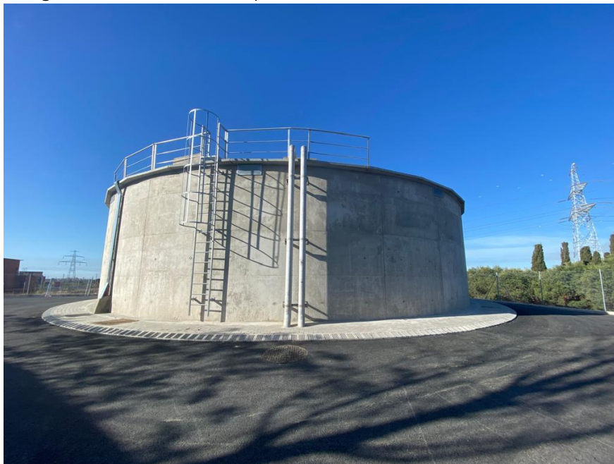
Fotografia 5. Vista exterior del dipòsit 2.
