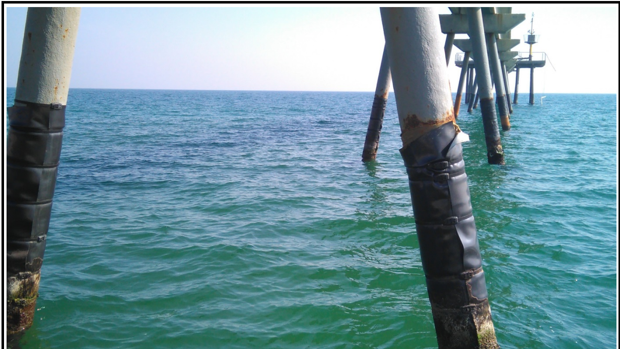
Imatge 3.- Pilot metàl·lic núm. 29B amb el revestiment parcial de la camisa.
