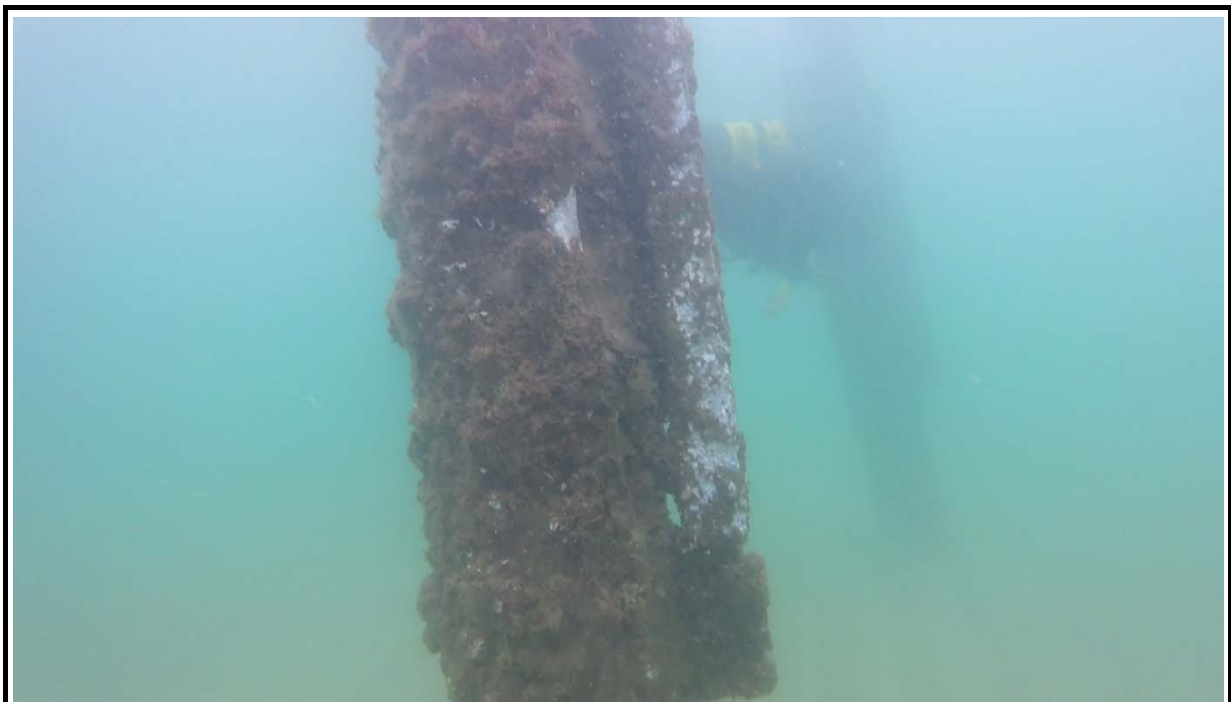
Imatge 44.- Ànode de sacrifici del pilot metàl·lic núm. 31M.
