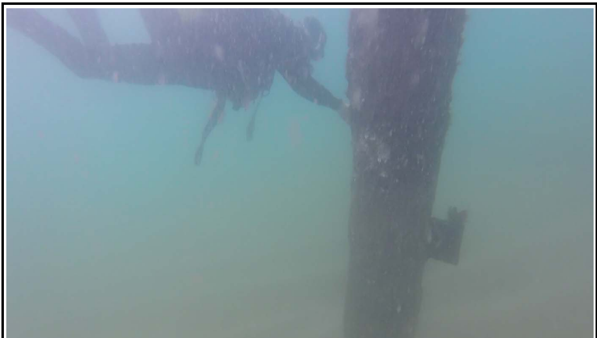
Imatge 50.- Pilot metàl·lic núm. 34M sense ànode de sacrifici.
