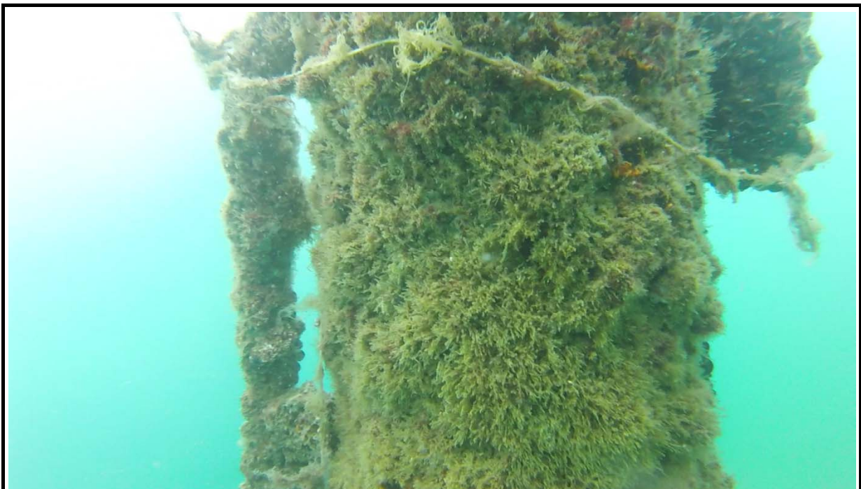
Imatge 26.- Pilot metàl·lic núm. 22M sense ànode de sacrifici.
