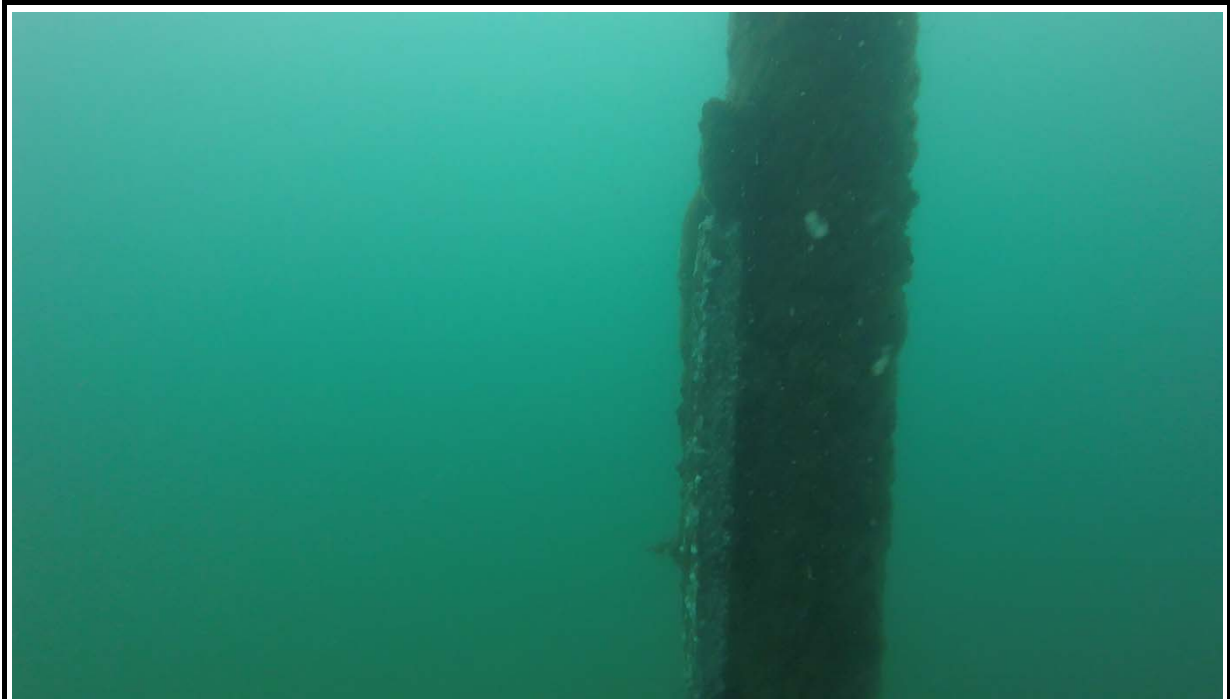
Imatge 19.- Ànode de sacrifici del pilot metàl·lic núm. 15.
