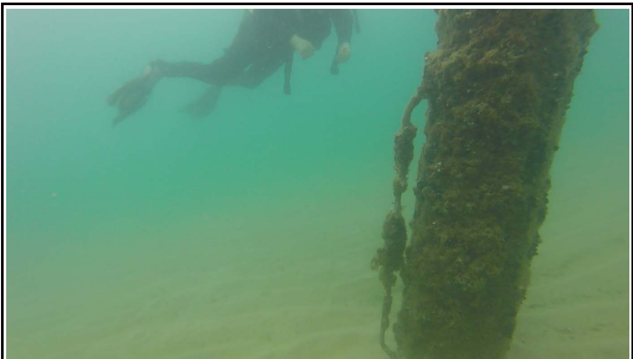
Imatge 36.- Pilot metàl·lic núm. 27M sense ànode de sacrifici.
