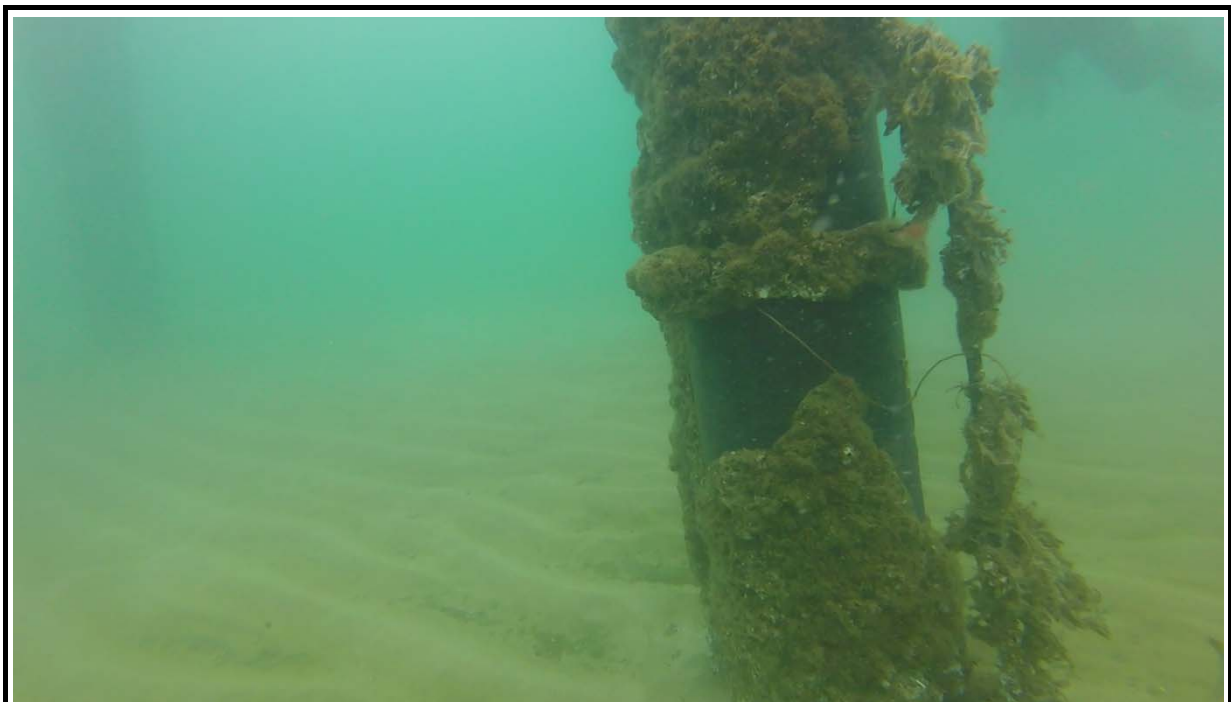
Imatge 34.- Pilot metàl·lic núm. 26M sense ànode de sacrifici.
