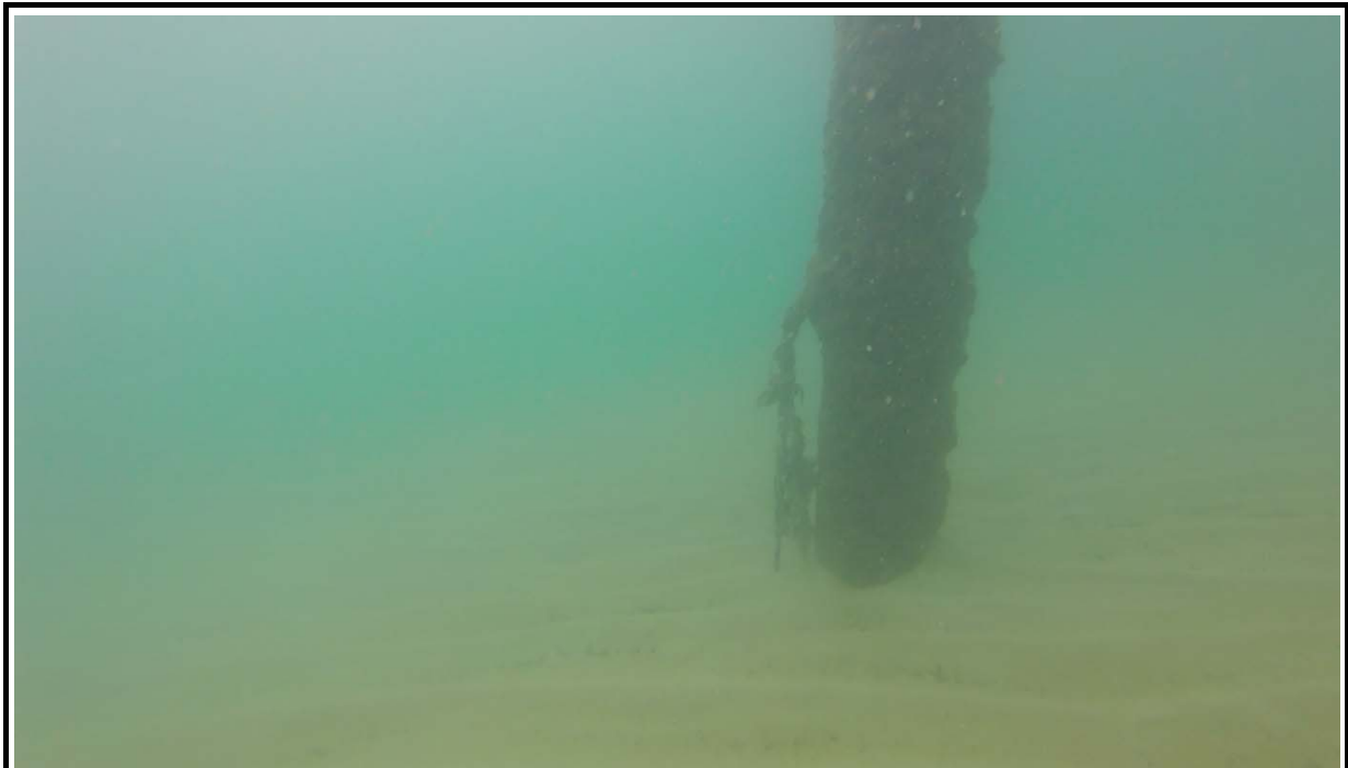
Imatge 37.- Pilot metàl·lic núm. 28B sense ànode de sacrifici.
