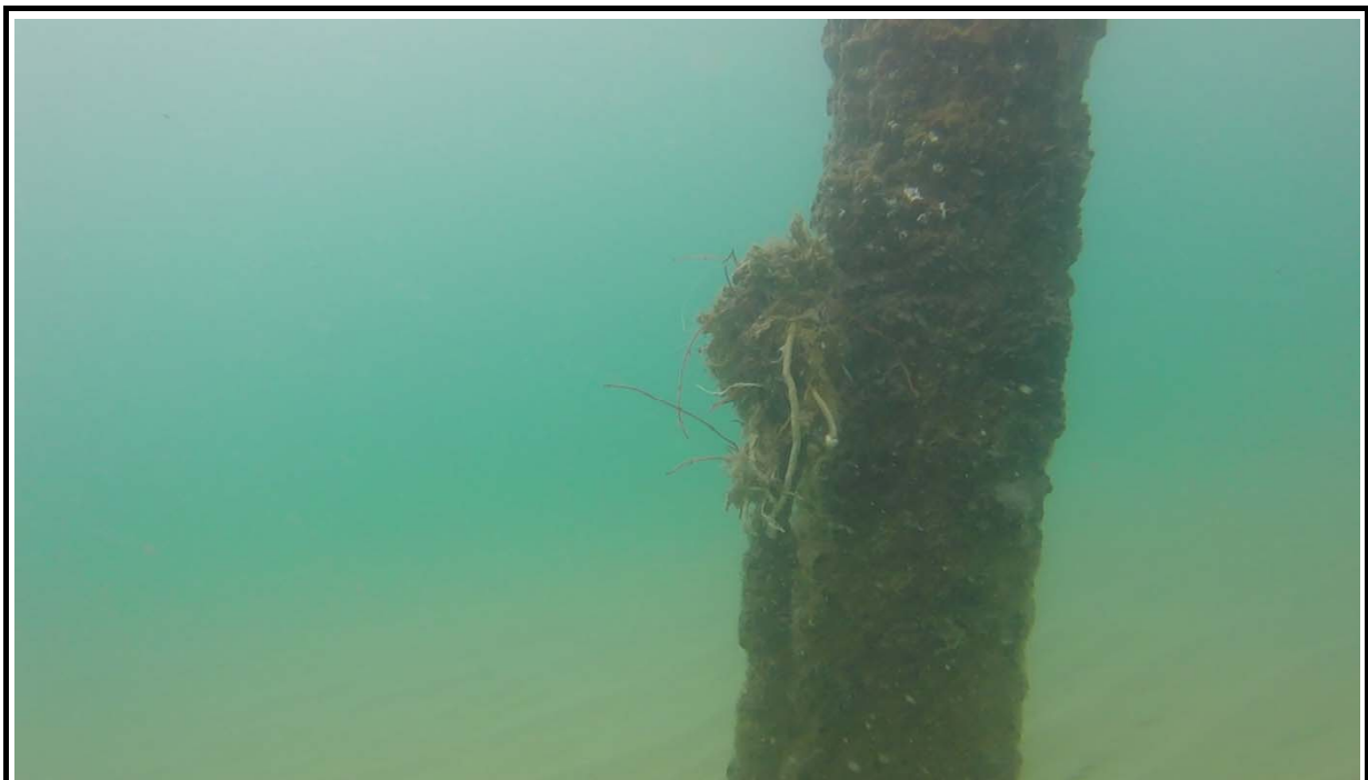
Imatge 38.- Pilot metàl·lic núm. 28M sense ànode de sacrifici.
