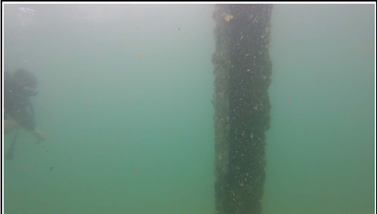
Imatge 45.- Ànode de sacrifici del pilot metàl·lic núm. 32B.
