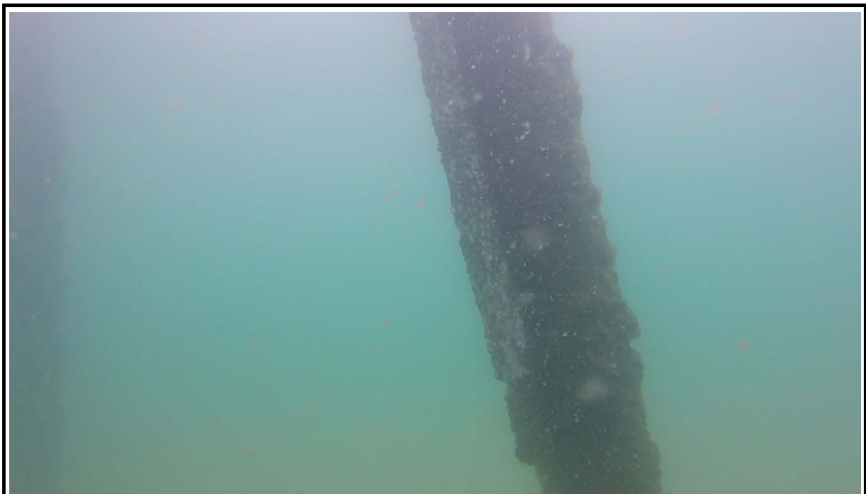
Imatge 42.- Ànode de sacrifici del pilot metàl·lic núm. 30M.
