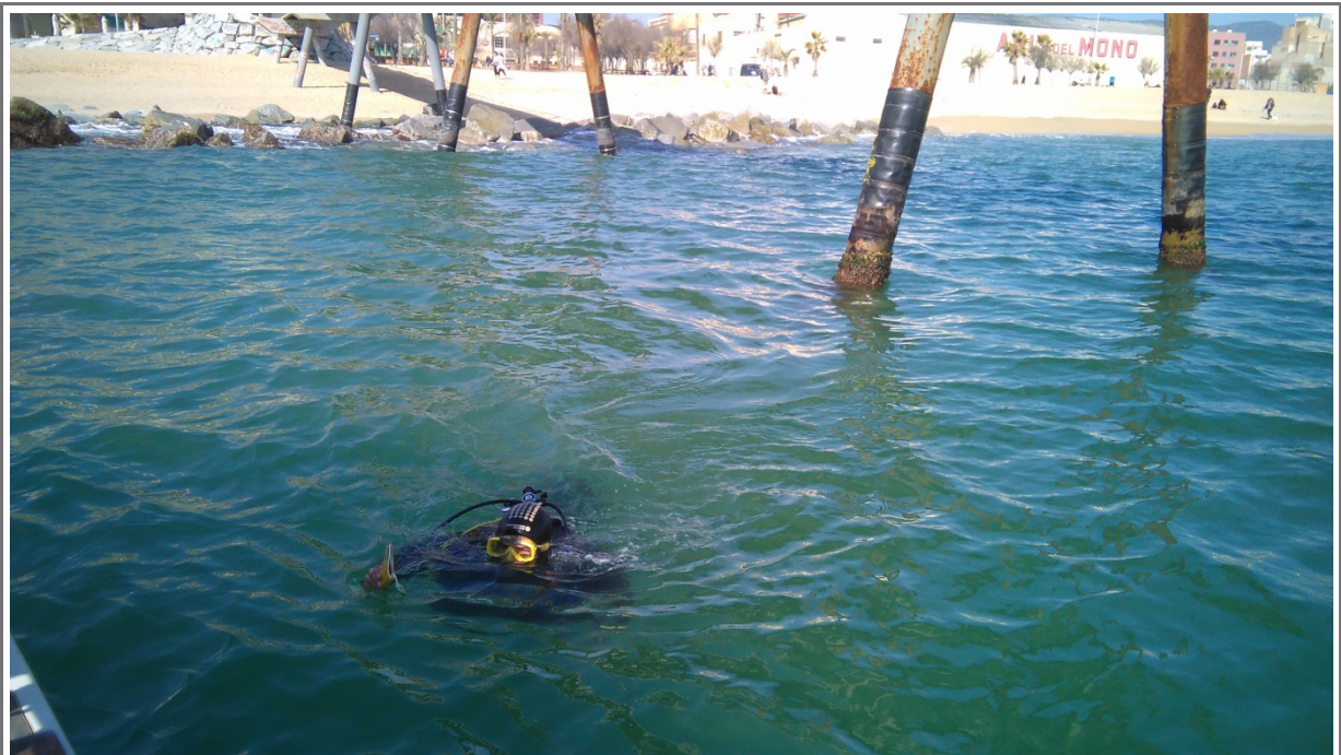
Figura 2.- Tècnic realitzant una filmació submarina als pilots metàl·lics del Pont del Petroli.
