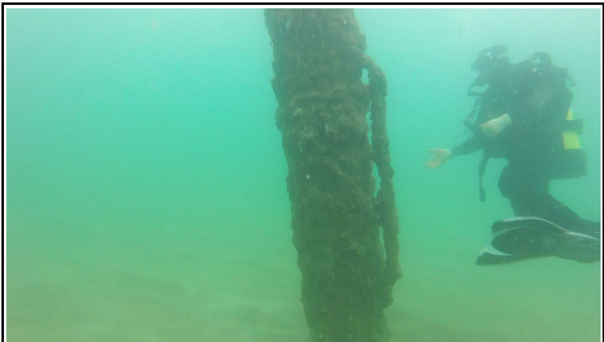
Imatge 32.- Pilot metàl·lic núm. 25M sense ànode de sacrifici.
