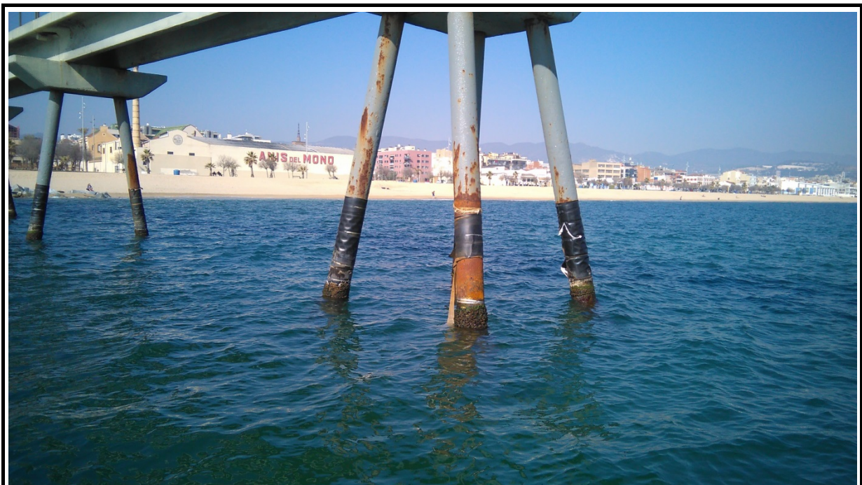
Imatge 2.- Pilot metàl·lic núm. 30B amb el revestiment parcial de la camisa.
