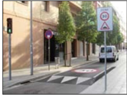
Gual sobreelevat a l'inici d'una Zona 30 - Granollers
